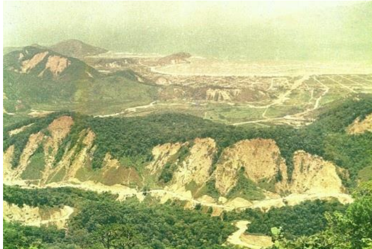
Figura 4: Cicatrizes do escorregamento de 1967 nas escarpas da Serra do Mar em Caraguatatuba/SP.
