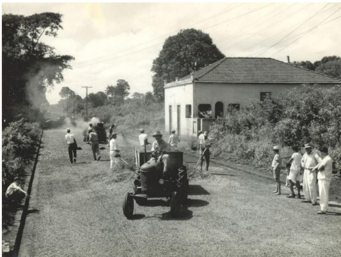
Figura 14 – Obra de asfaltamento de rua no Morro do Cipó, atual Parque Municipal Morro do São Bento 16 , Tony Miyasaka, 1962.
