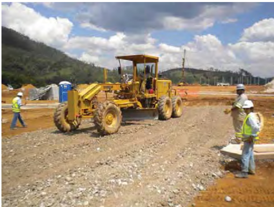
Figura 01 – Uso de RCD em estrutura de pavimento.
