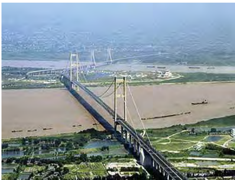
Figura 25: Ponte Akashi Kaykio, a mais longa ponte suspensa do mundo. Fonte: Tom Harris, 1999.
