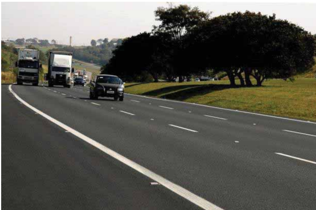
Figura 29: Pavimento asfáltico. Fonte: Itimara Figueiredo, 2012.
