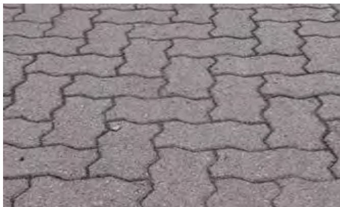
Figura 32: Pavimento semi-rígido intertravado. Fonte: ABCP, 2011.
