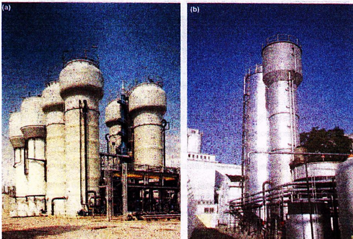
Figura 08: Reatores em escala industrial – (a) Sistema air lift e manta de lodo granular expandida localizados na Holanda; (b) CIRCOCX (a frente na foto) e sistema IC (circulação interna) localizado em uma cervejaria no Brasil.
