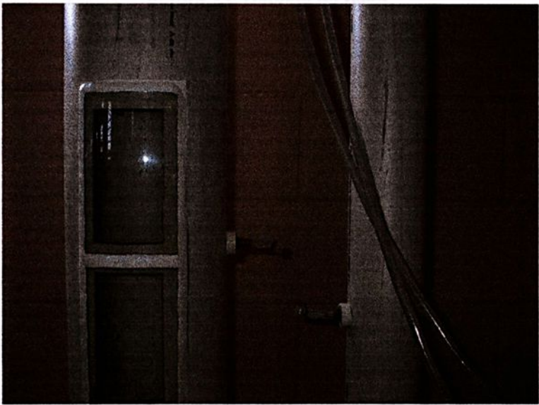
Figura 22: Detalhe do tubo de subida e descida.
