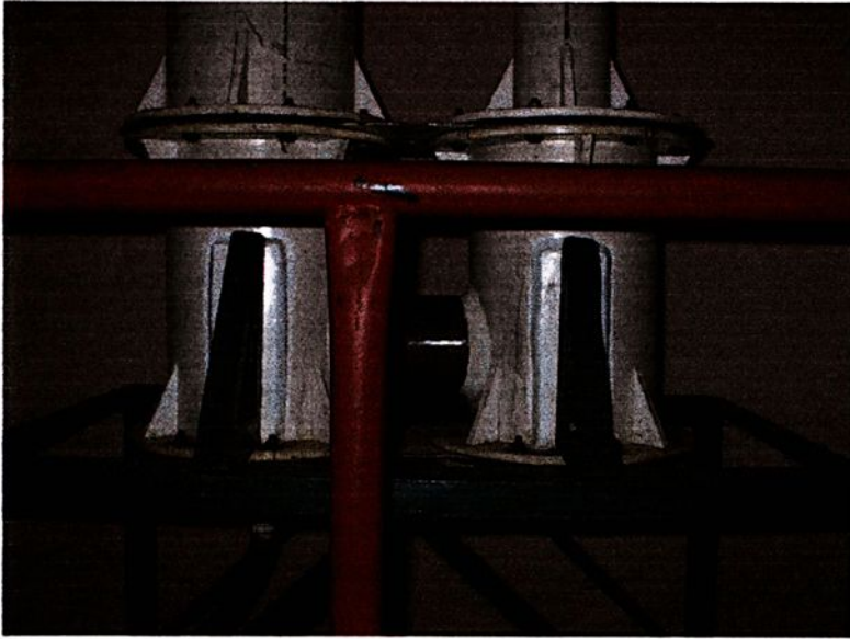
Figura 23: Detalhe da base.
