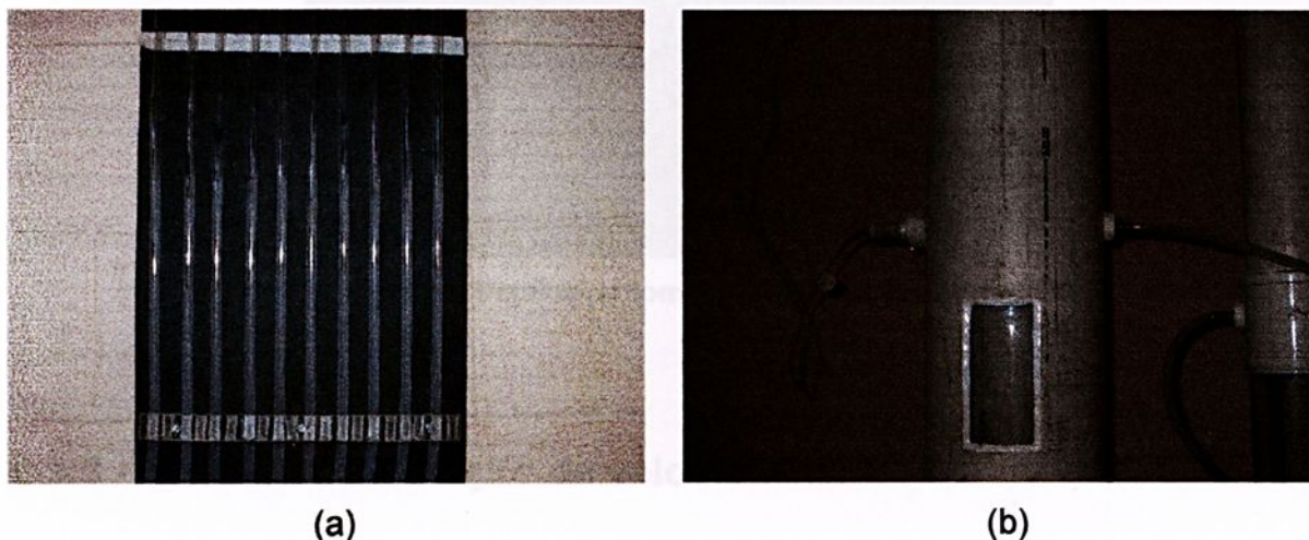
Figura 25: Detalhe do quadro de piezômetros e mangueiras que interligam as tomadas ao quadro.
