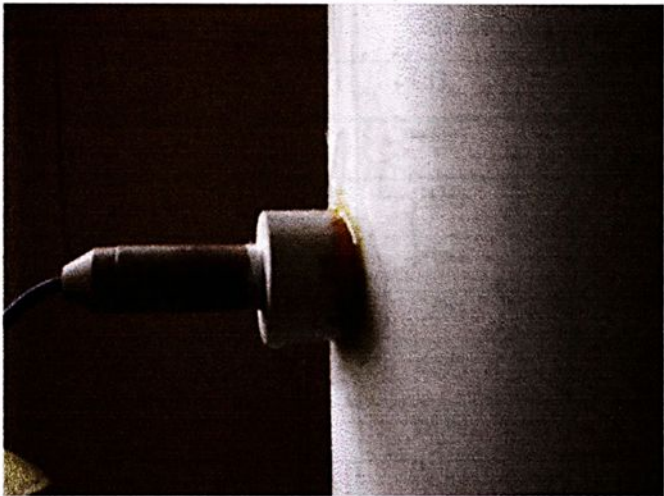
Figura 30: Detalhe da sonda locada no tubo de descida.
