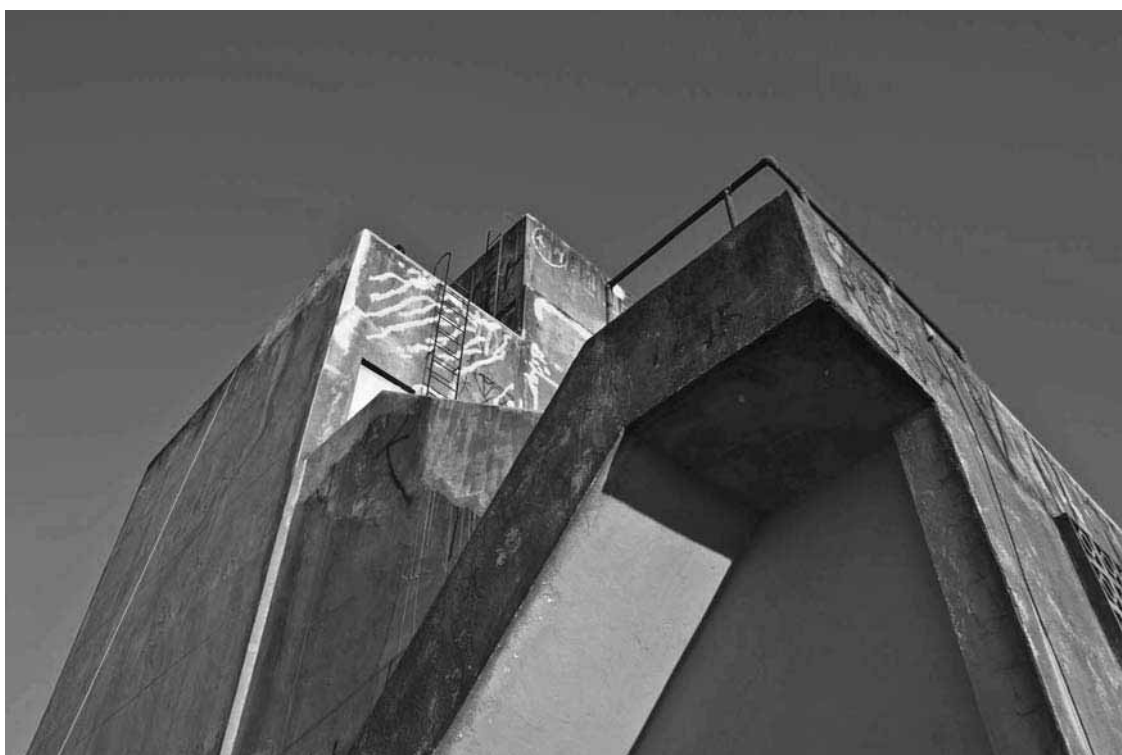
fig. 18 : Locação : 1º lance de escadas
