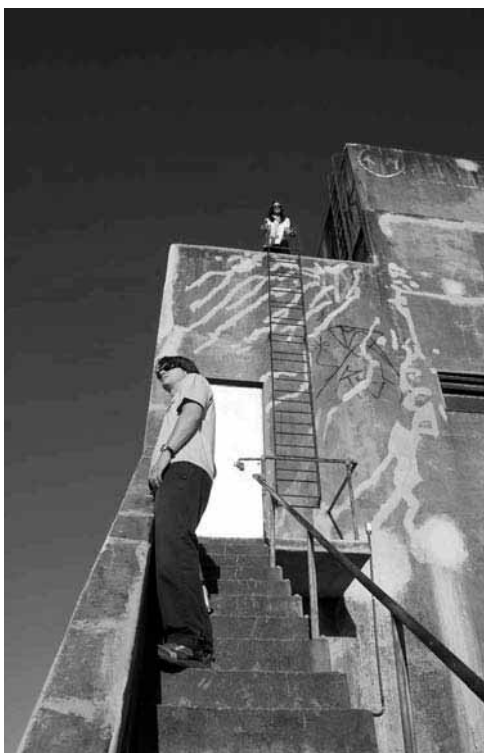
fig. 20 : Locação : 2º lance de escadas
