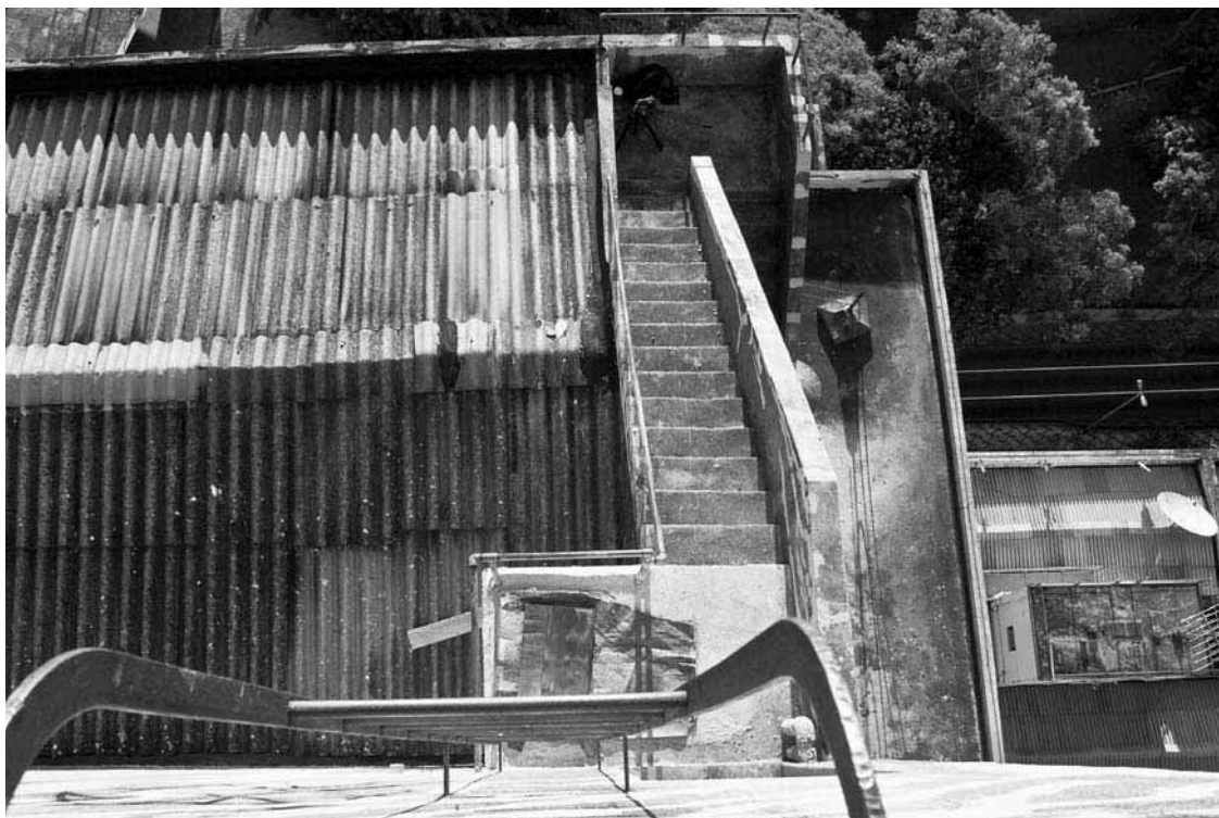
fig. 22 : Locação : Vista das escadas
