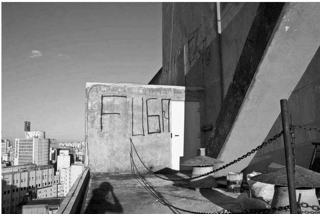
fig. 17 : Locação : Saída do poço do elevador
