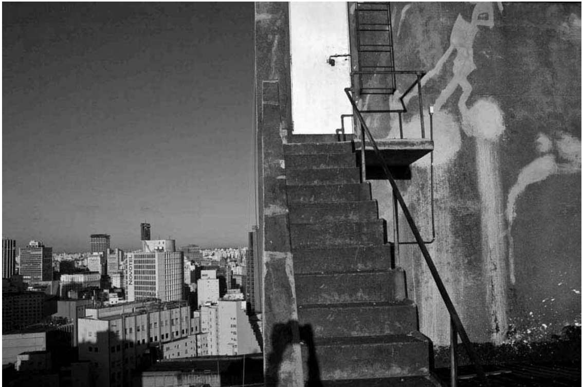
fig. 19 : Locação : 2º lance de escadas
