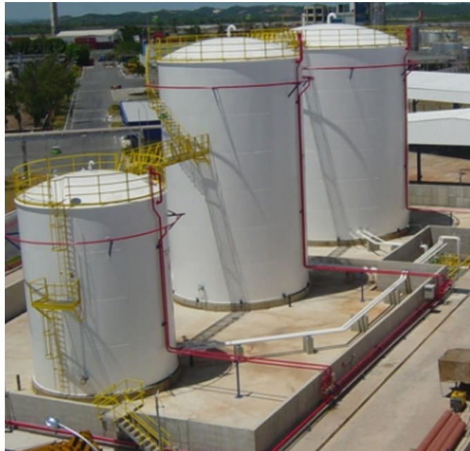
Figura 2 - Bacia de contenção concretada
