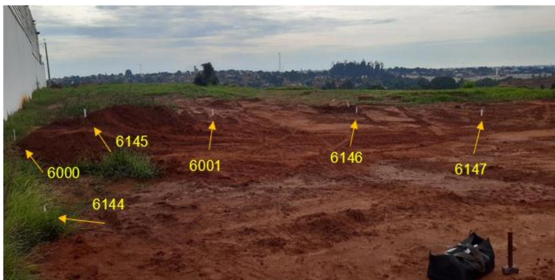
Figura 41 – Estacas locadas na obra com numeração indicada. Fonte: O autor
