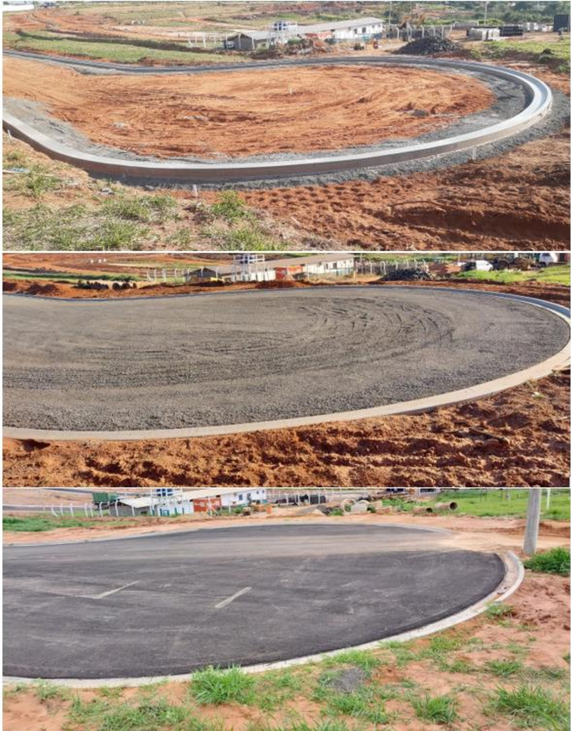
Figura 45 – Pavimentação do cul-de-sac no decorrer da obra. Fonte: O autor
