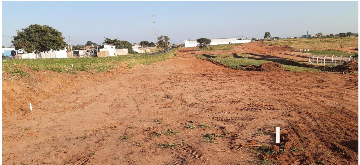
Figura 39 – Vista do trecho antes da construção da guia. Fonte: O autor
