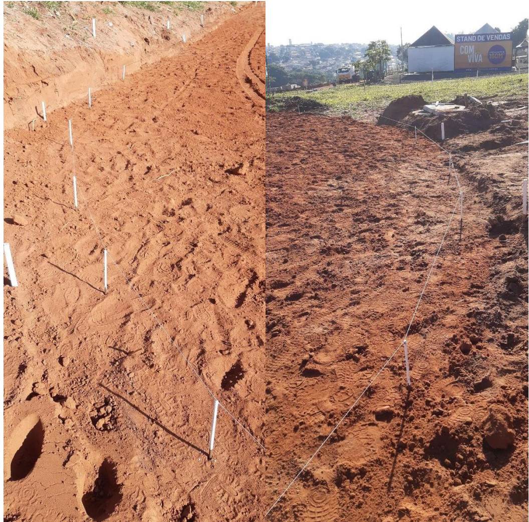
Figura 43 – Utilização de ferros para o alinhamento. Fonte: O autor
