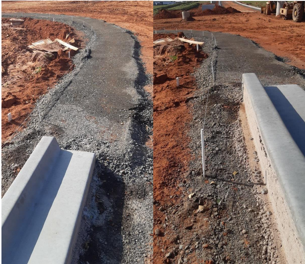
Figura 44 – Camada de regularização de brita. Fonte: O autor
