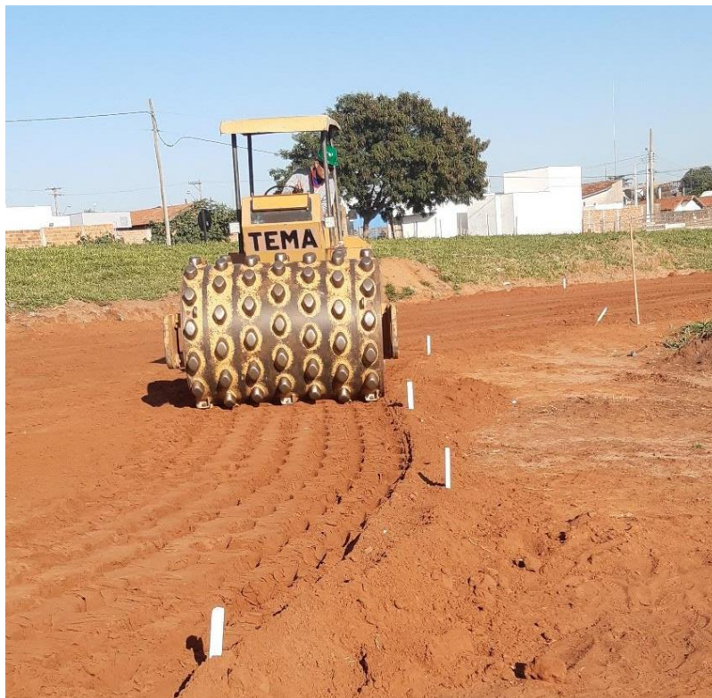
Figura 42 – Processo de compactação do solo. Fonte: O autor
