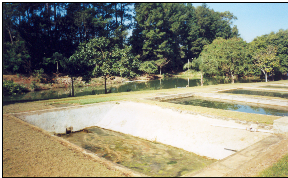
Figura1. Vista dos tanques estudados.
