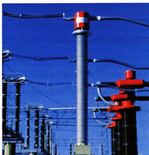
Figura 1.4 – Unidade de medição – TP e TC ópticos – para 525 kV [1].
