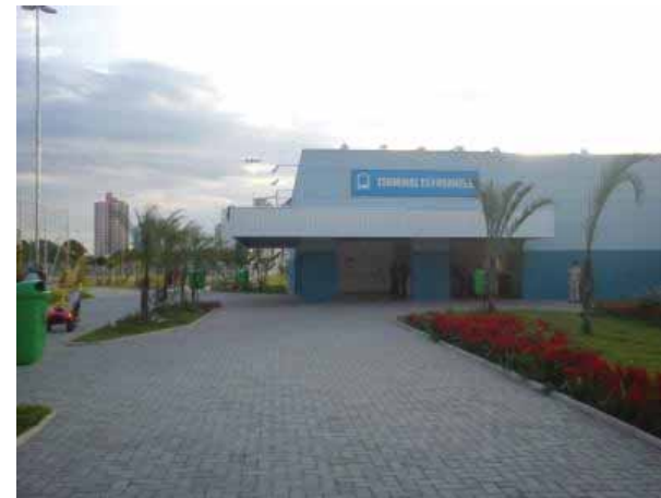
Figura 37 – Novo terminal de ônibus construído no espaço
