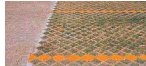
Figura 94 – Exemplo de pisograma e piso intertravado de concreto usados nos estacionamentos
