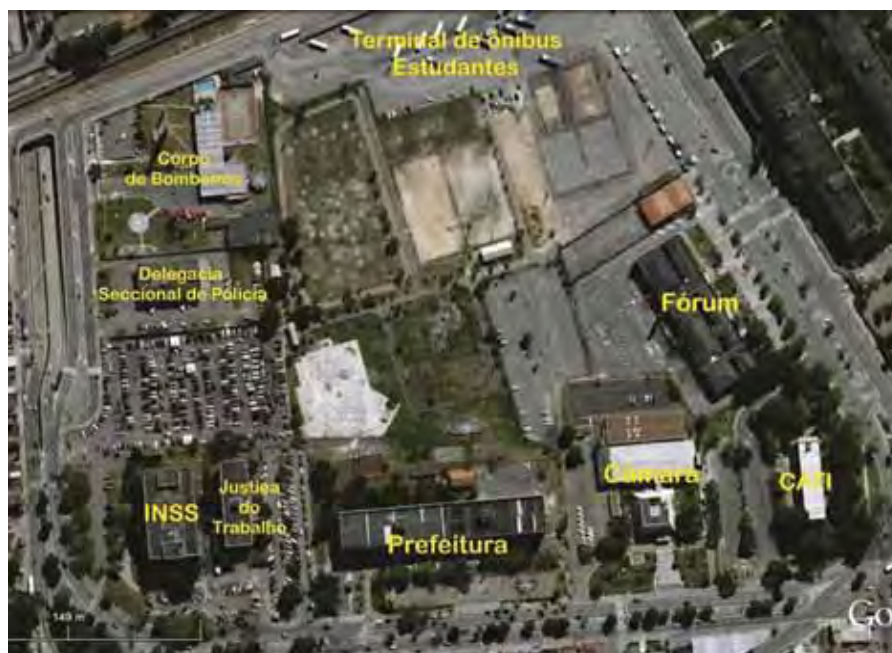
Figura 07 – Prédios do entorno
