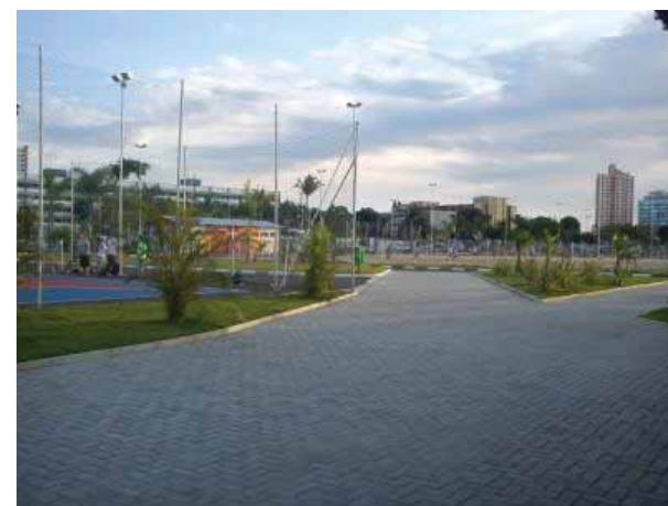
Figura 38 – Piso trocado em frente ao acesso do Terminal
