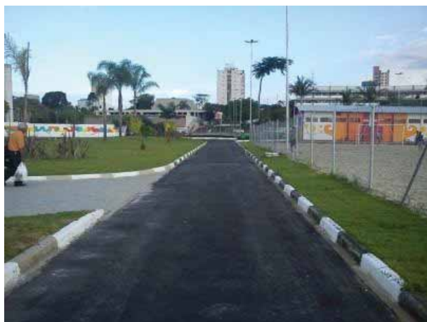
Figura 39 – Caminhos de asfalto que se encontram com os novos pisos Fonte: Arquivo pessoal, 2011
