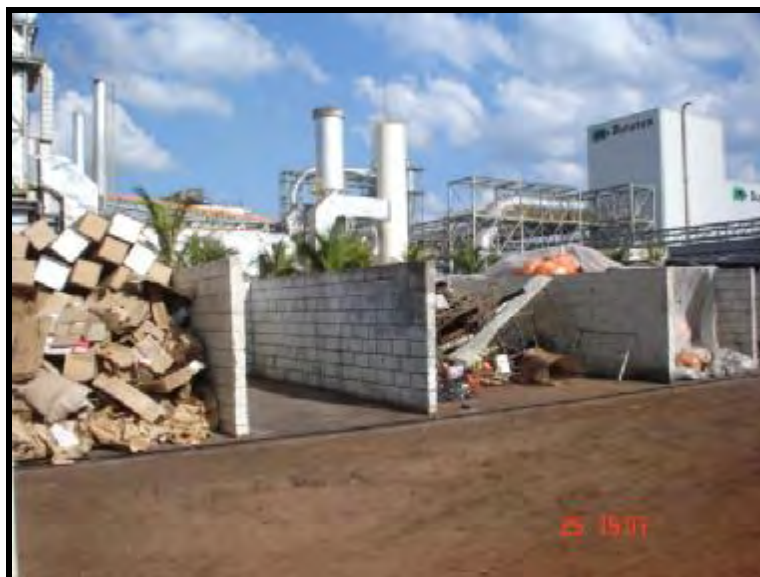
Figura 11 - Vista parcial da área de armazenamento temporário dos resíduos - lado esquerdo.
