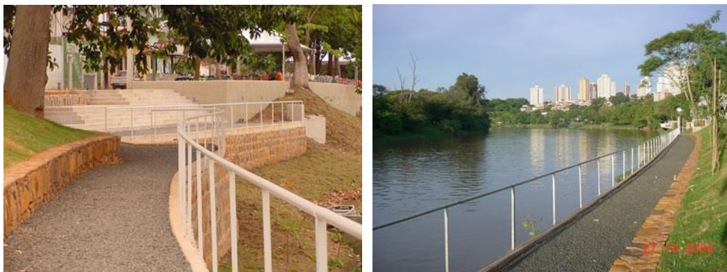
Figura 14 - Fotos da Rua do Porto com as obras de revitalização concluídas em 2004
