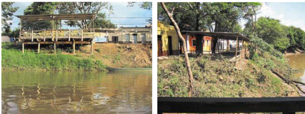
Figura 13 - À esquerda, deques dos restaurantes da Rua do Porto antes da revitalização. À direita, a condição de "barranco" da margem do rio antes da intervenção
