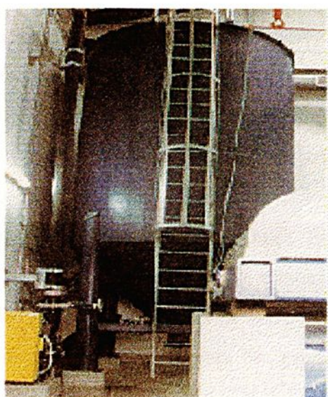
FIGURA 30 - Vista geral do tanque separador de areia.
