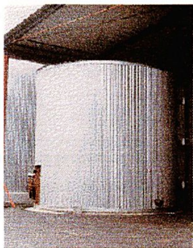
FIGURA 34 - Reservatório de acumulação de água do processo.
