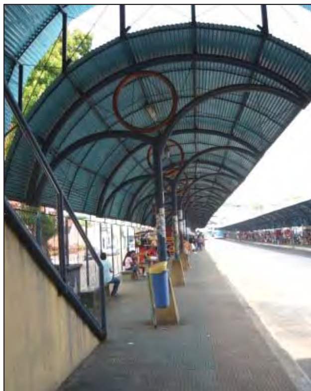
Figura 19. Terminal 01 – Constantino Nery: detalhe da cobertura interior. Fonte: Trabalho de Campo, 2009.
