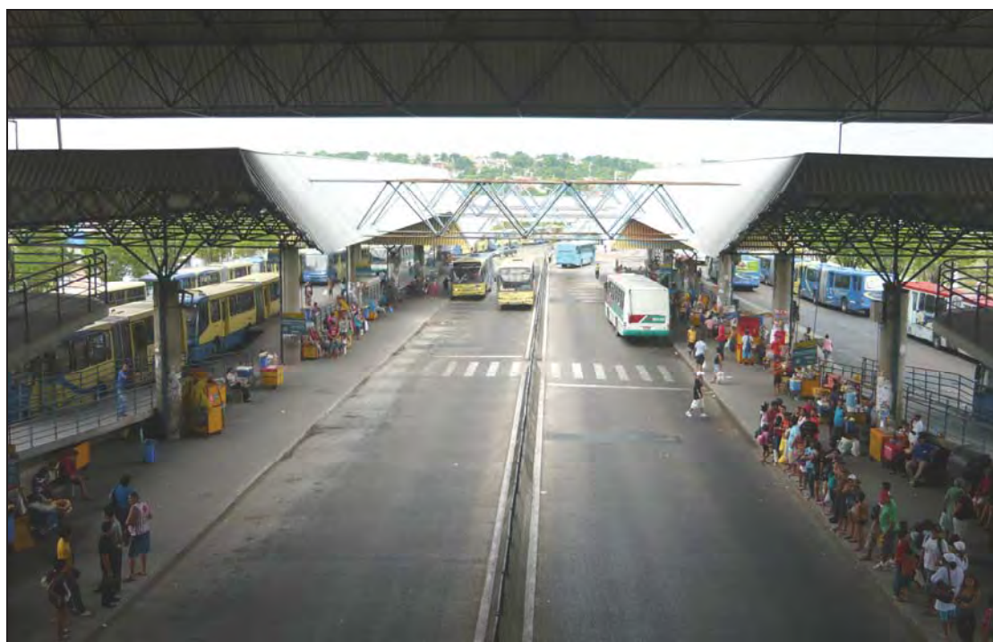
Figura 38. Terminal 04 – Jorge Teixeira: Interior. Fonte: Trabalho de Campo, 2009.
