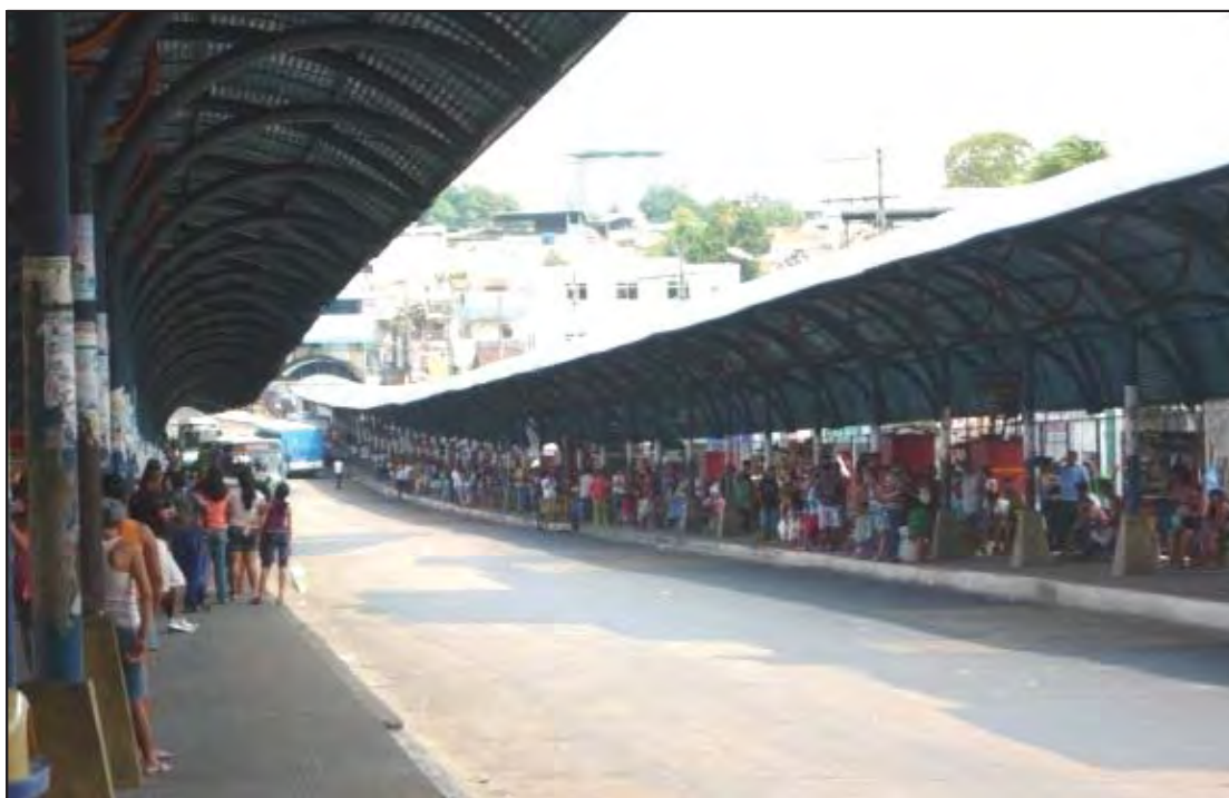
Figura 18. Terminal 01 – Constantino Nery: interior. Fonte: Trabalho de Campo, 2009.
