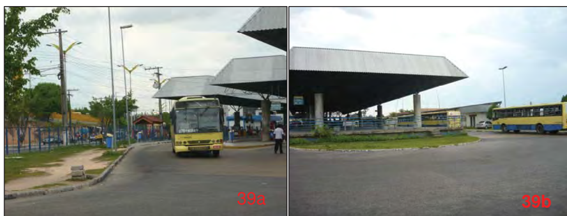
Figura “39a” (entrada centro-bairro: vista lateral esquerda) e Figura “39b” (entrada centro - bairro: vista lateral direita): Terminal 05 – São José. Fonte: Trabalho de Campo, 2009. Org.: AMORIM, 2010.
