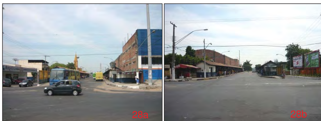
Figura “28a” (entrada bairro-centro) e Figura “28b” (entrada centro-bairro): Terminal 02 Cachoeirinha. Fonte: Trabalho de Campo, 2009. Org.: AMORIM, 2010.
