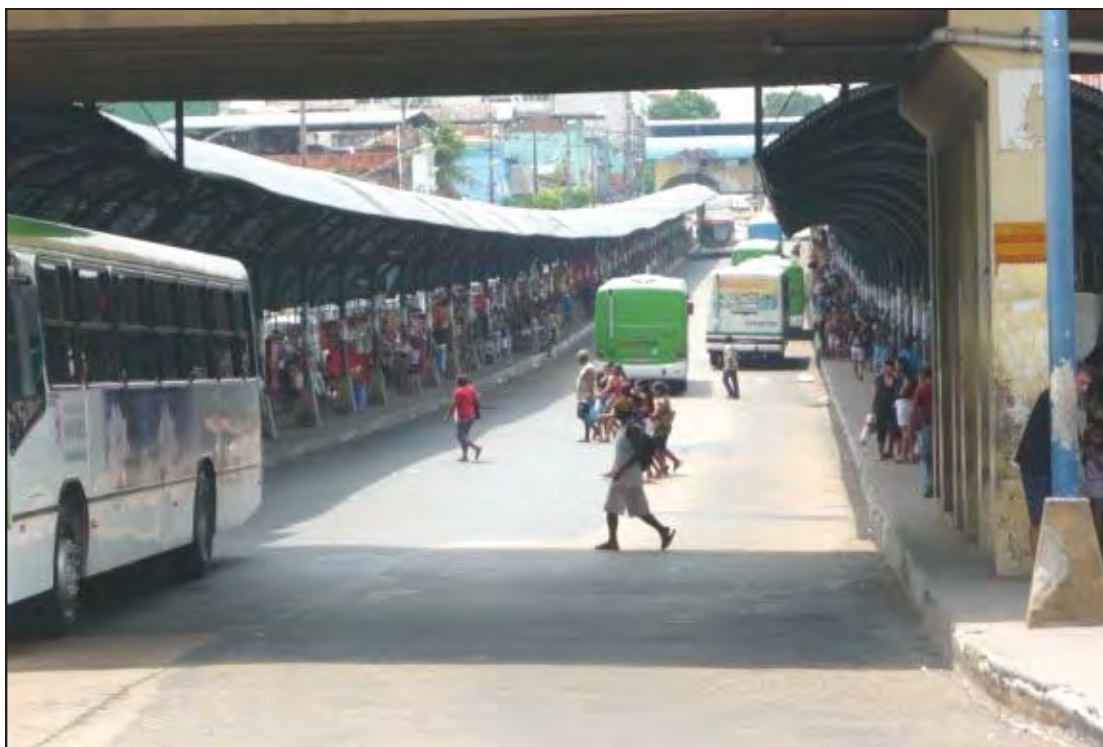
Figura 17. Terminal 01 Constantino Nery: interior. Fonte: Trabalho de Campo, 2009.
