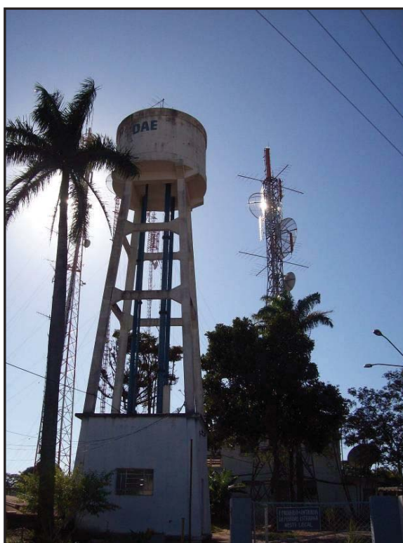
Foto 26: Torre de água na ETA
