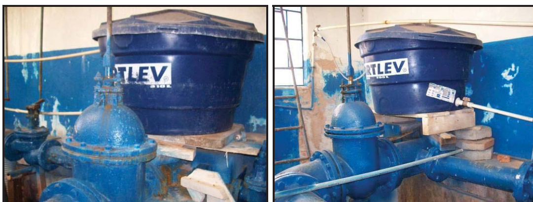
Foto 24: Caixas nas quais são realizados, respectivamente, os processos de cloração e de fluoretação. Fonte: Trabalho de campo, 2011.
