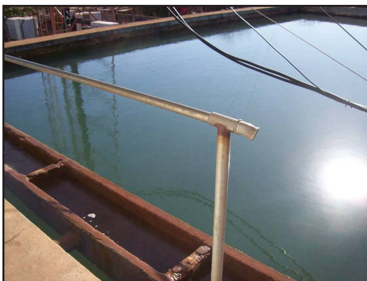
Foto 22: Tanque de decantação
