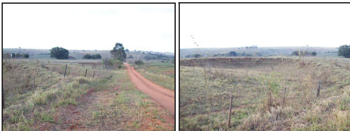
Foto 31: Recuperação da Estrada do Colégio Agrícola com a formação de bacias de retenção.
