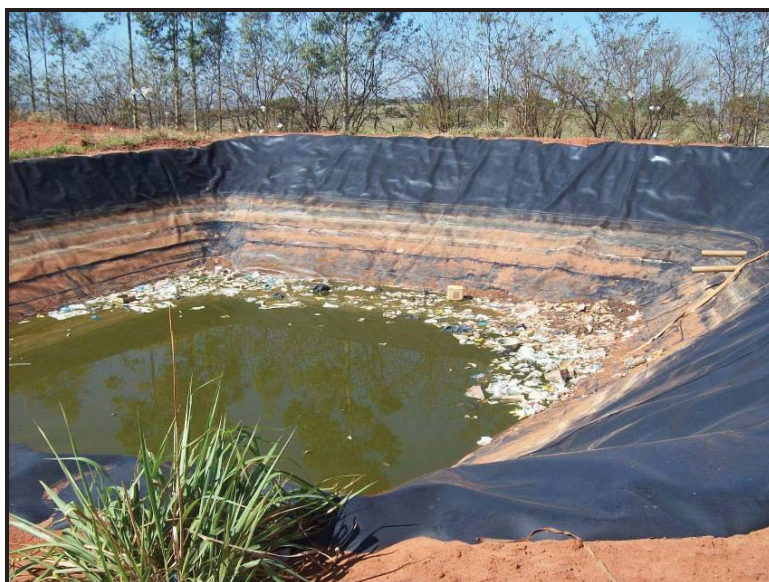
Foto 28: Represa impermeabilizada que recebe o chorume Fonte: Trabalho de campo, 2011.
