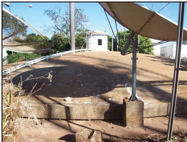
Foto 25: Reservatório de água na ETA
