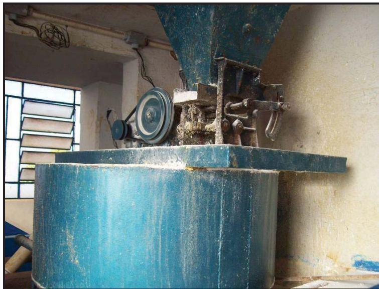
Foto 21: Máquina que controla a introdução de sulfato de alumínio para a decantação.
