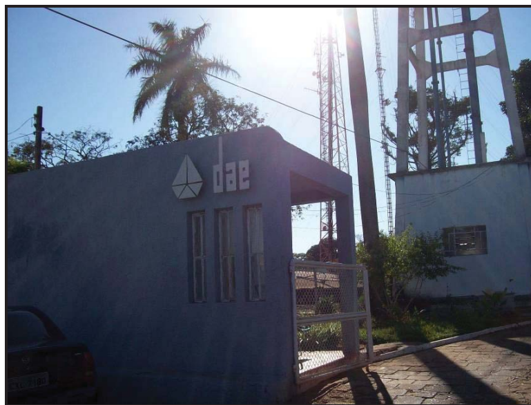
Foto 18: Estação de Tratamento de Água (ETA) do DAE de Presidente Venceslau Fonte: Trabalho de campo, 2011.
