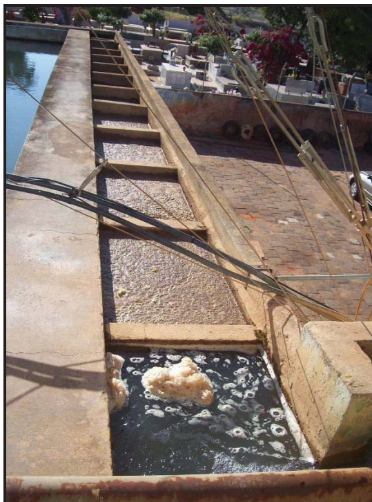
Foto 20: Processos de coagulação e floculação Fonte: Trabalho de campo, 2011.
