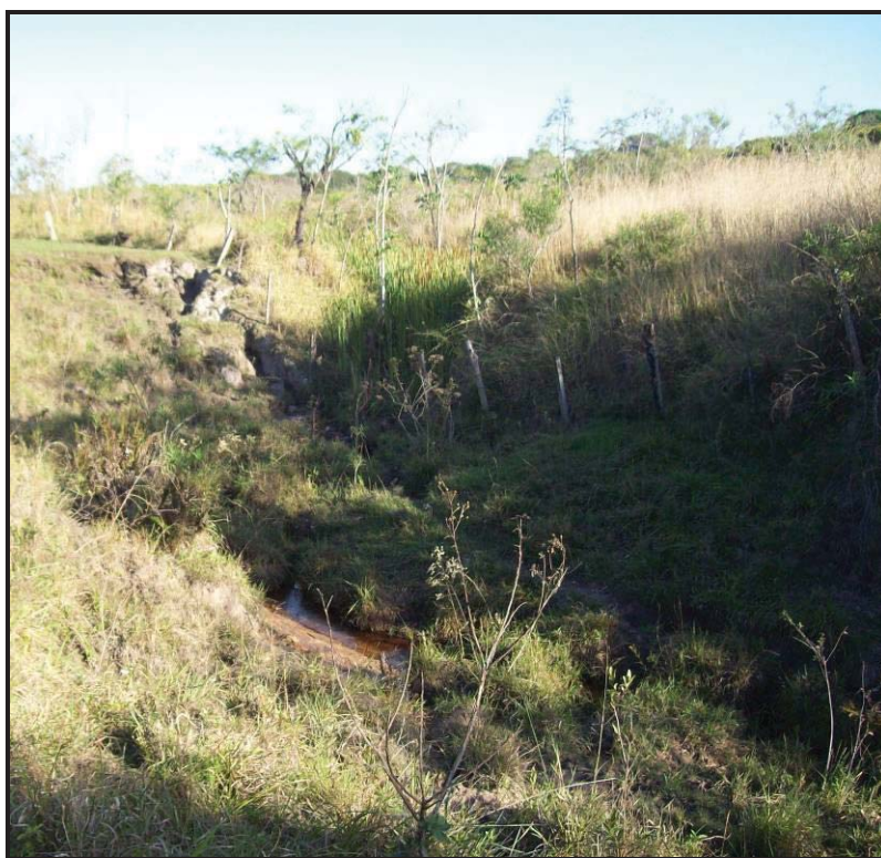
Foto 06: Área de APP sem a presença da mata ciliar, próximo à nascente principal do Córrego do Veado.
