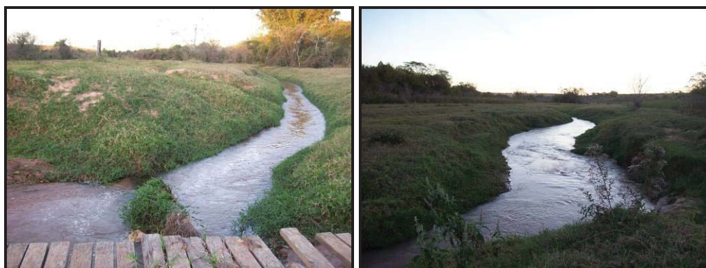
Foto 03: Córrego do Veadinho à montante e à jusante da ponte em estrada rural Fonte: Trabalho de campo, julho de 2011.
