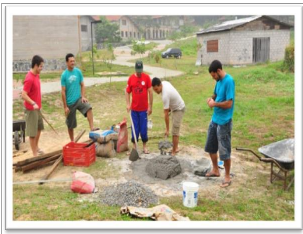
Foto 7 - Dia de trabalho (atividade da construção) Fonte: Trabalho de Campo na ENFF em julho de 2011.
