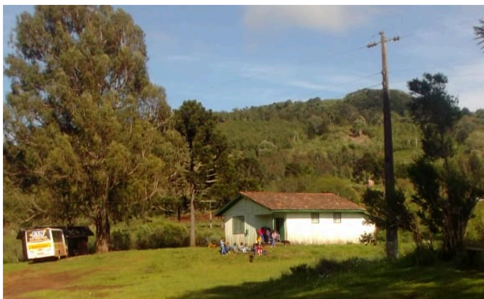
Imagem 5 - Fotografia da Escola Isolada Municipal Lageado Bonito
