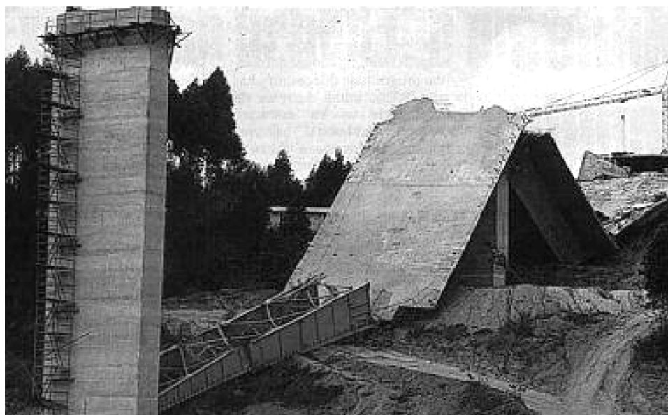
Figura 8 – Ponte do Rio Injaka
