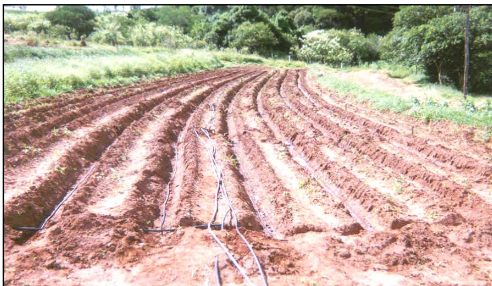
Figura 5: Montagem do experimento (jan/fev/2000). Detalhe para as linhas laterais dentro do sulco.
