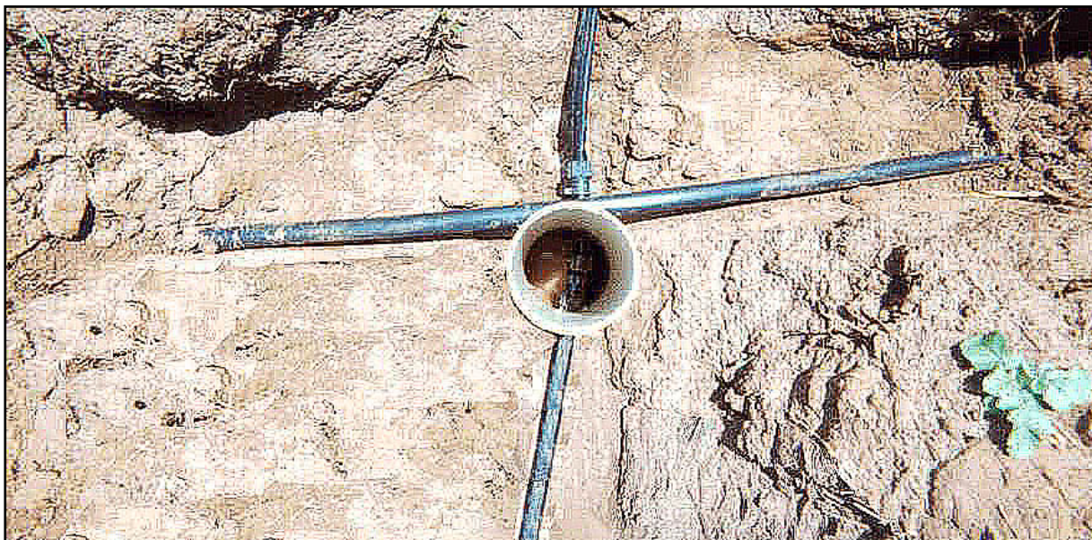
Figura 8. Montagem do experimento. Detalhe para o tubo de proteção da válvula final de linha.
