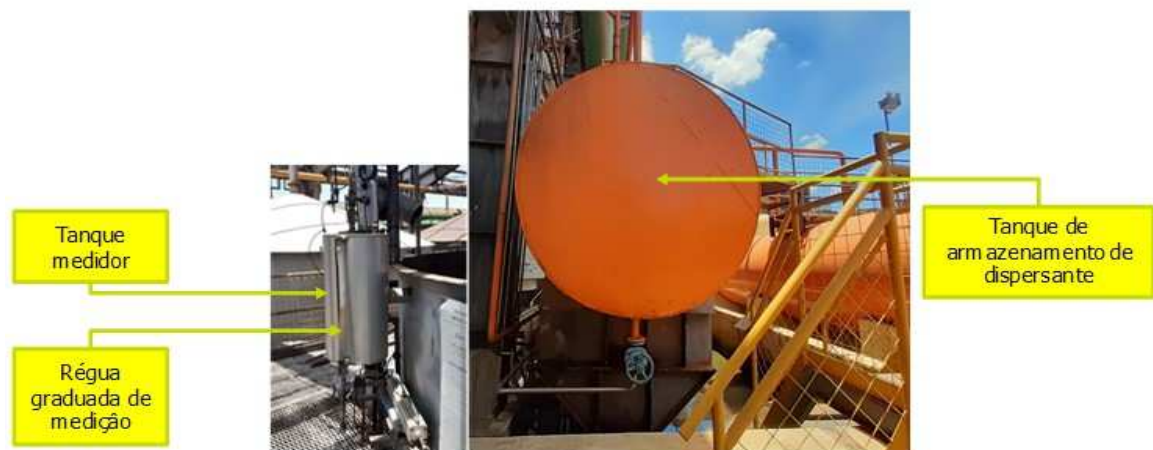
Figura 12. Tanques de Dispersante. Fonte: próprio autor.
