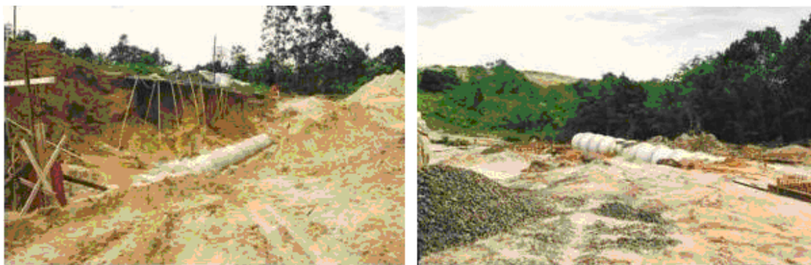
Figura 7 – Construção da ETE - SABESP e canalização da nascente no P 2
