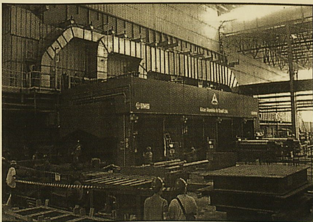
FIGURA 14 - Tandem mill Alcan Brasil (fase final de montagem) [29]
