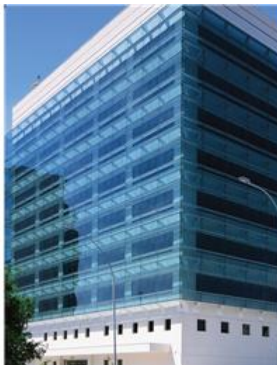
Figura 7 – Dupla camada de vidro, diminuição da incidência luminosa noturna no entorno do edifício (Edifício Cidade Nova na cidade do Rio de Janeiro), publicada na Revista Vidro Impresso (2012).
