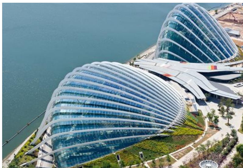
Figura 5 – Telhado reflexivo, em edifício sustentável - Gardens by the Bay, em Cingapura ( www.abravidro.org.br/blog/ , publicado em Outubro de 2012, acessado em Novembro de 2012).
