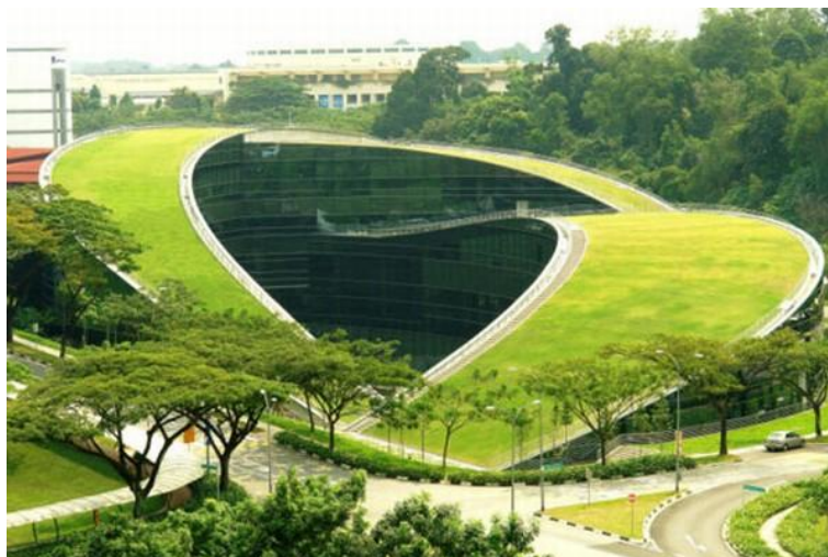
Figura 6— Telhado verde - Escola de Arte, Design e Comunicação da Universidade Tecnológica de Nanyang, em Cingapura ( www.coletivoverde.com.br/telhado-ecologico/ , publicado em Julho de 2011, acessado em Outubro de 2012).
