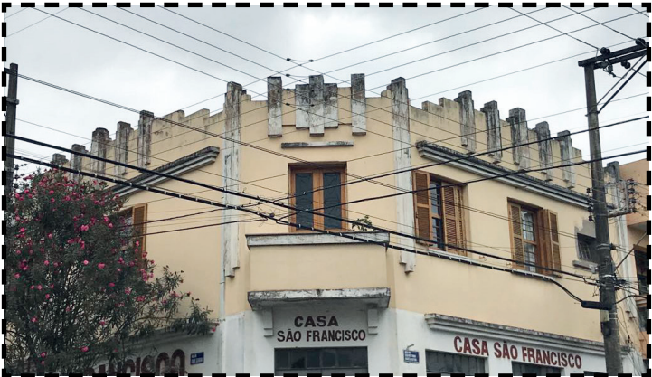
Figura 103: Fachada do imóvel. Fonte: Acervo da autora, 2018.
