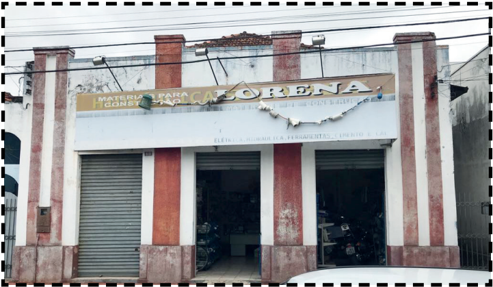
Figura 96: Fachada do imóvel. Fonte: Acervo da autora, 2018.
