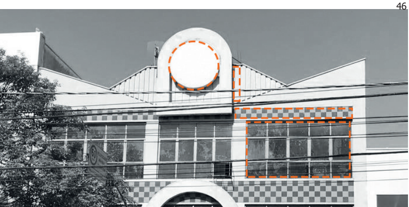
Figuras (45 e 46): Fachadas com Superfície de cobertura e ornamentos destacados.
