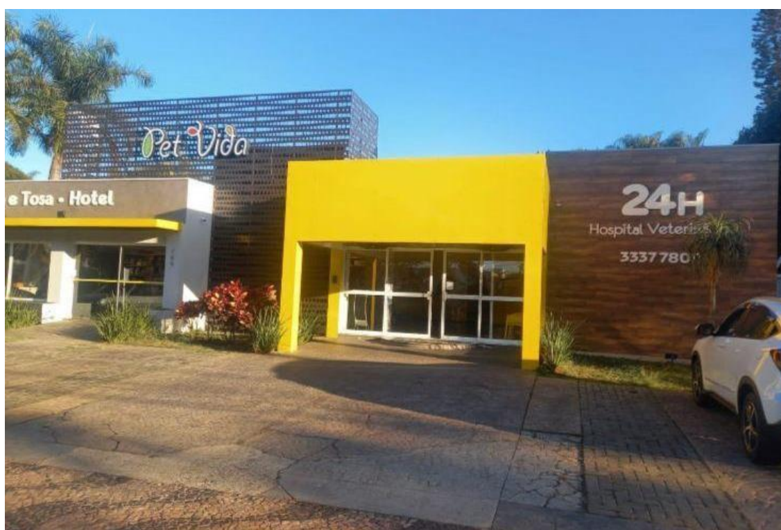
Figura 11. Fachada do Hospital Veterinário PET VIDA - Araraquara, SP. Fonte: autor.
