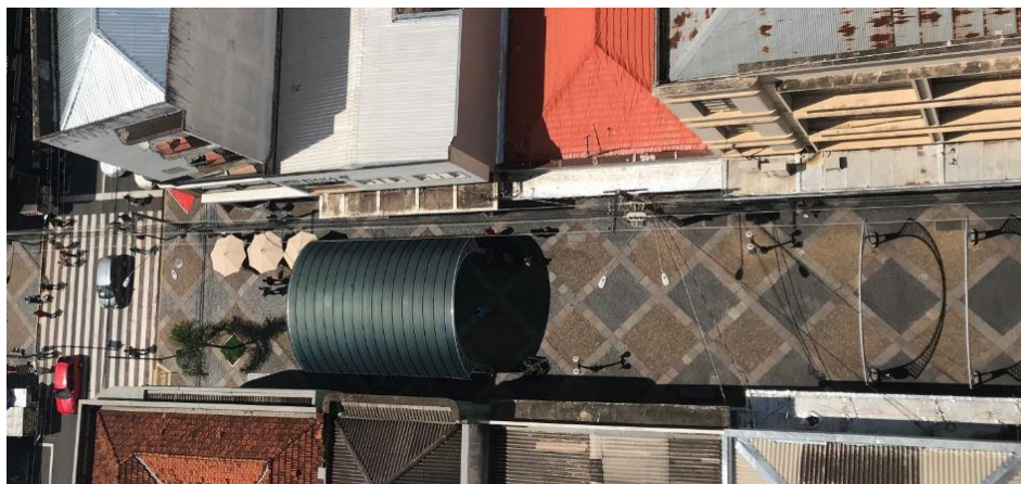
Figura 38 - Vista do 16 andar do Edifício Comercial, localizado na quadra 4 do Calçadão, onde pode-se ver o piso e a disposição dos Arcos.
