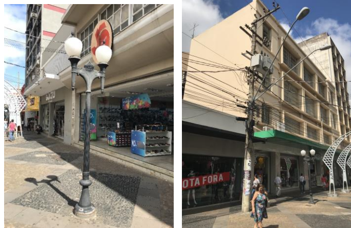
Figura 45 - Poste em ferro e poste padrão municipal.
