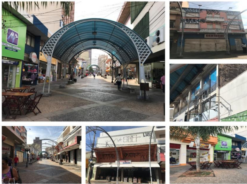
Figura 65 - Problemas atuais encontrados na Quadra 2.
