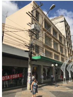
Figura 40 - Prédio comercial antigo com fachada revitalizada após pintura.
