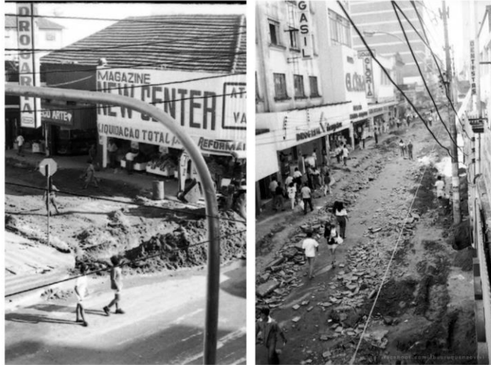
Figura 24 - Início da reforma da Rua para Calçadão, em 1991.
