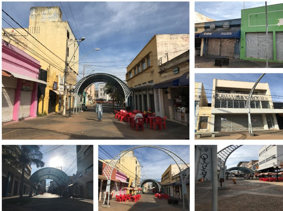
Figura 62 - Problemas atuais encontrados na Quadra 1.
