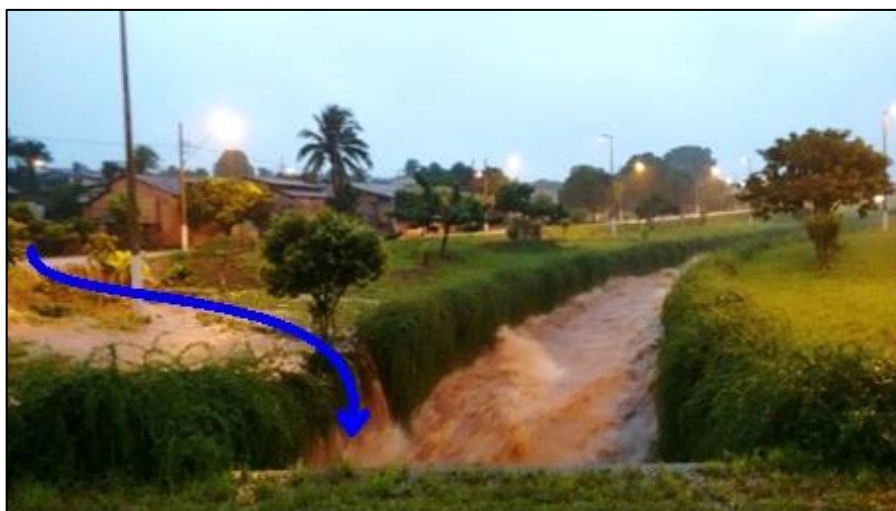
Figura 11 - Escoamento superficial em direção ao canal do córrego São José, localizado na Avenida José João Dib
