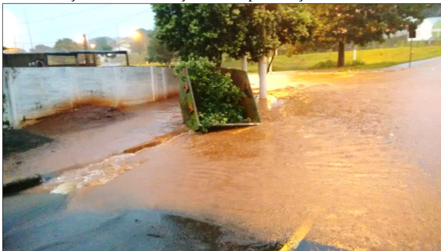
Figura 10 – Problemas de drenagem pluvial nas imediações da Avenida José João Dib: Caçamba de construção virada pela força da enxurrada
