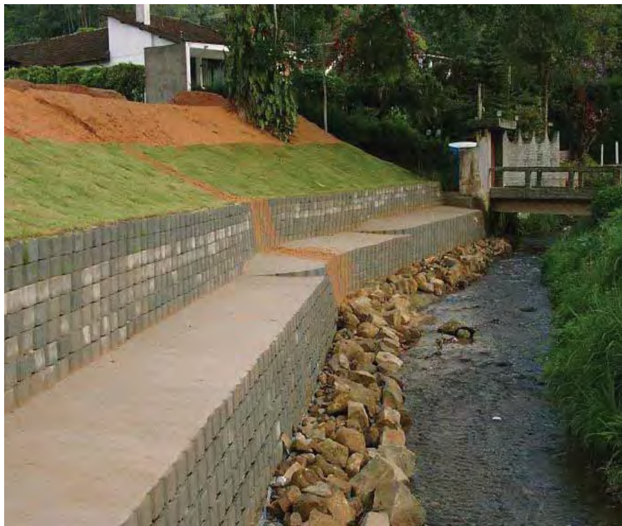
Figura 2 – Exemplo de muro segmental (Cedido por Brugger, 2011).
