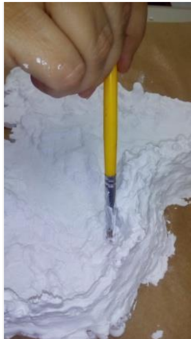
Figura 15 - Preenchimento de espaços onde não havia massa
