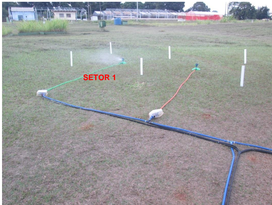
Figura 48a: Avaliação de alcance – Teste 8: Acionamento automático do Setor 1
