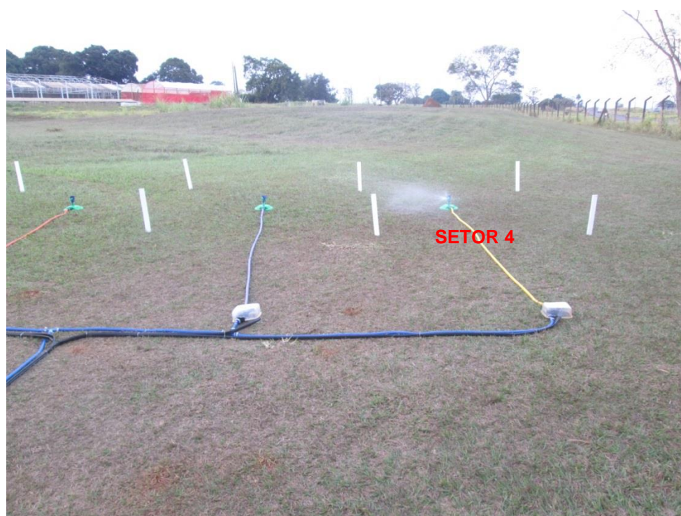
Figura 48d: Avaliação de alcance – Teste 8: Acionamento automático do Setor 4
