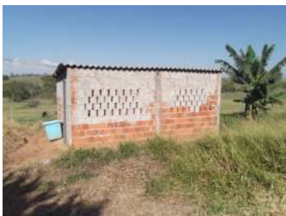
Foto 13 – Central de Armazenamento do tanque de abastecimento da estufa
