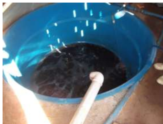
Foto 14 – Tanque de abastecimento da estufa
