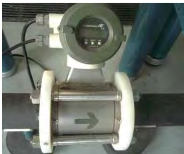
Figura 3.4 – Medidor de vazão eletromagnético Yokogawa, modelo ADMAG AE208MG.
