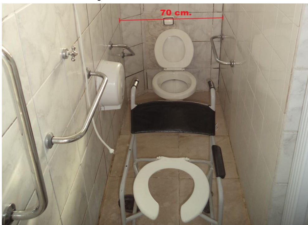
Figura 21 - Dimensões do banheiro
