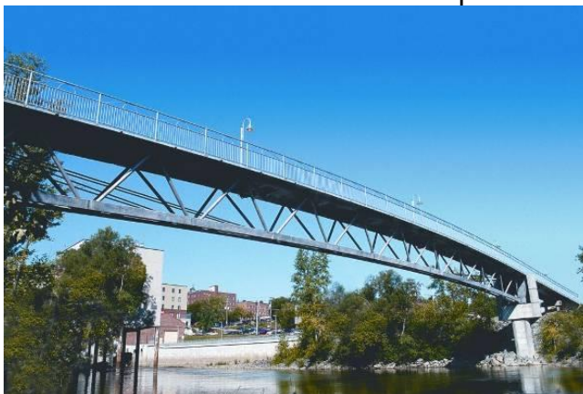
Figura 1 – Passarela confeccionada com o concreto de pós reativos, no Canadá
