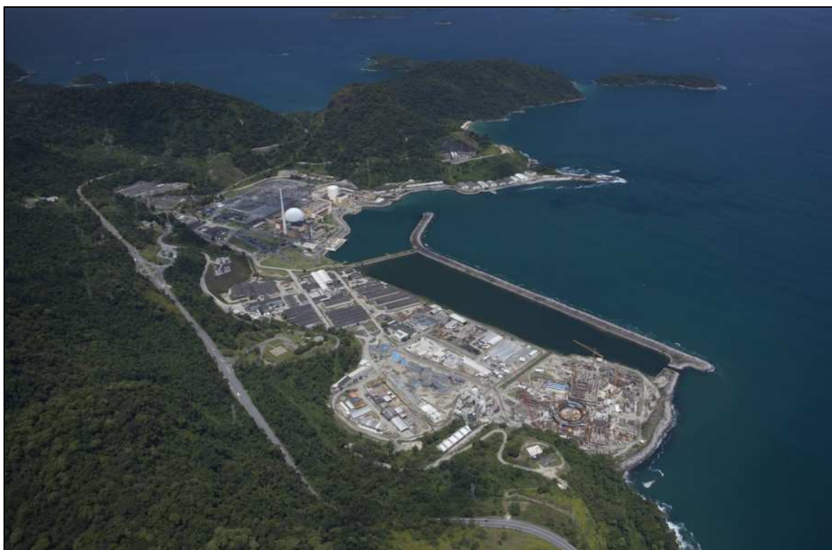
Figura 7 - Complexo CNAAA, Usinas Angra 1, Angra 2 e Angra 3
