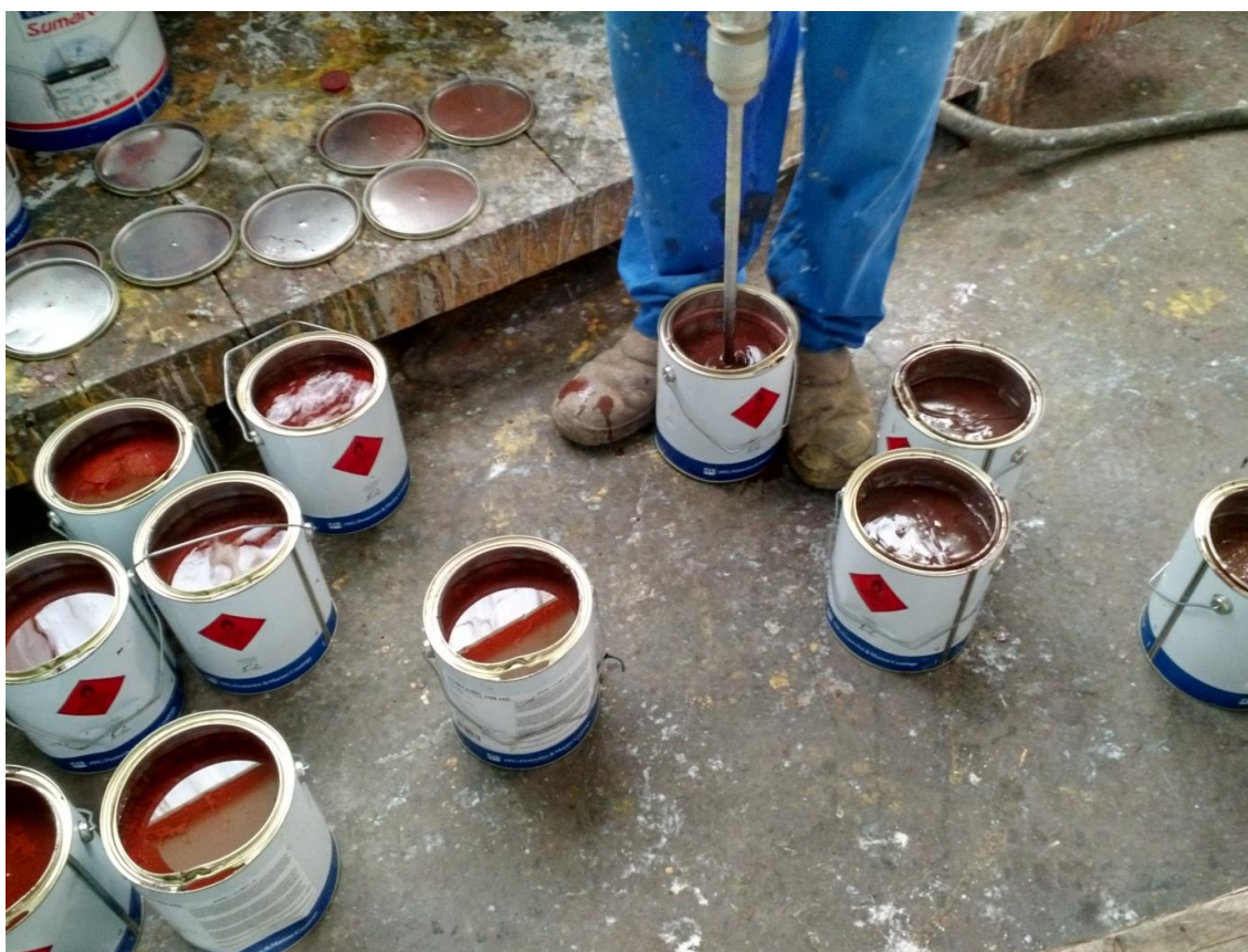
Figura 4: Mistura de tintas: Componente A e B com agitador pneumático
