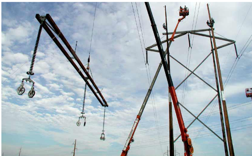
Figura 3 – Substituição de elementos estruturais em uma torre de transmissão.
