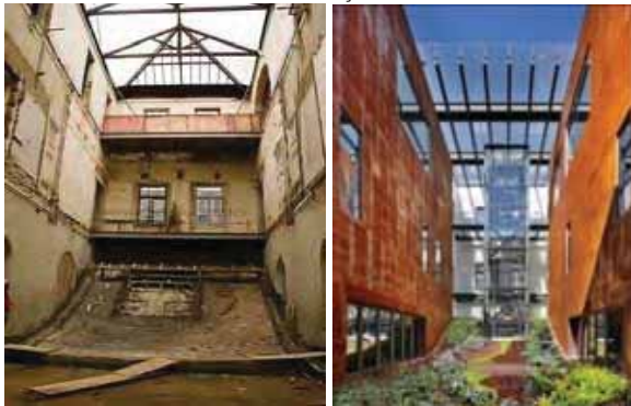
Figura 22 - Pátio interno antes e depois do projeto de intervenção.
