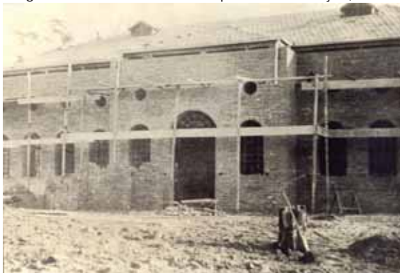
Figura 45 - Matadouro Municipal em construção, 1929.
