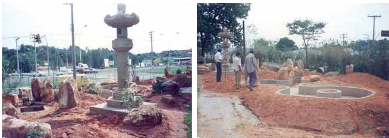
Figura 50 - Construção do jardim japonês.
