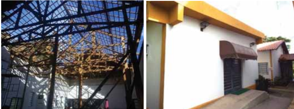
Figura 73 - Cobertura com treliças de madeira e anexos.
