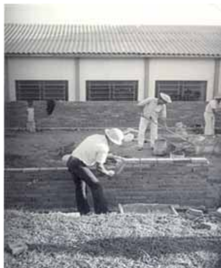
Figura 49 - Construção dos novos anexos.
