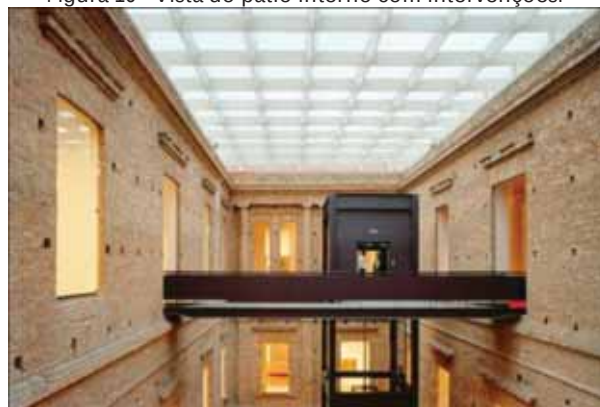
Figura 16 - Vista do pátio interno com intervenções.
