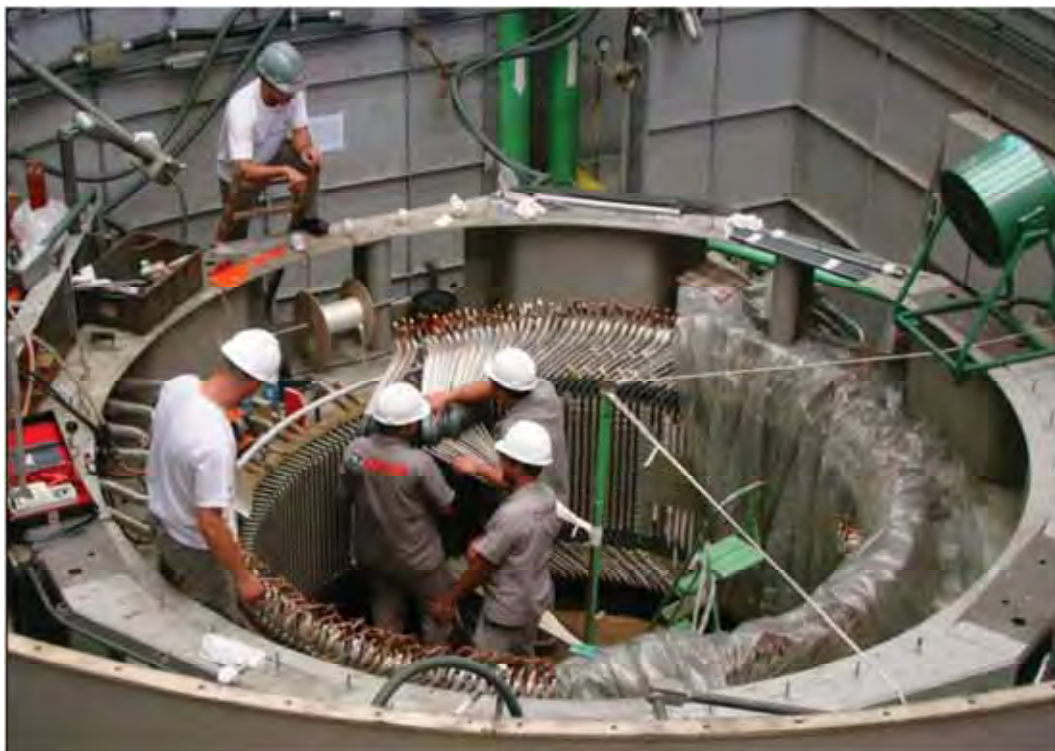
Figura 6 - Substituição do Enrolamento de um Gerador (Fonte: UOL 8 ).
