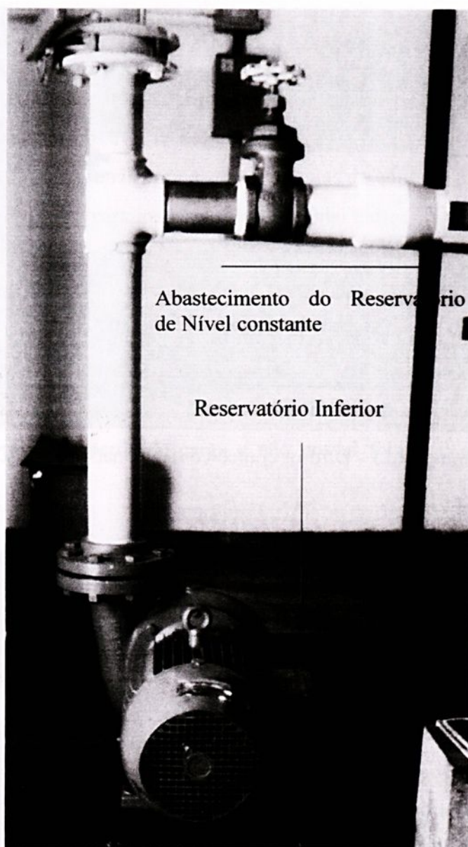
Figura B.22 - Sistema de abastecimento do túnel.
