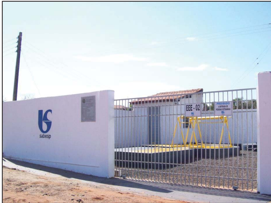
Figura 6: Estação Elevatória de Esgoto construída pela SABESP em Magda. Fonte: Trabalho de Campo, 2011.
