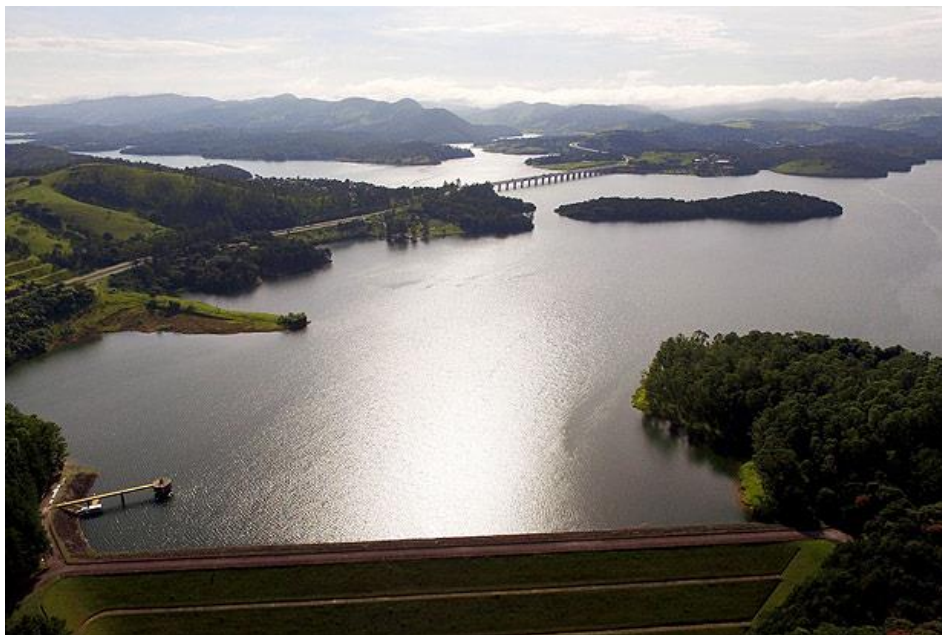
Figura 12 – Vista panorâmica do reservatório de Atibainha (SP)
