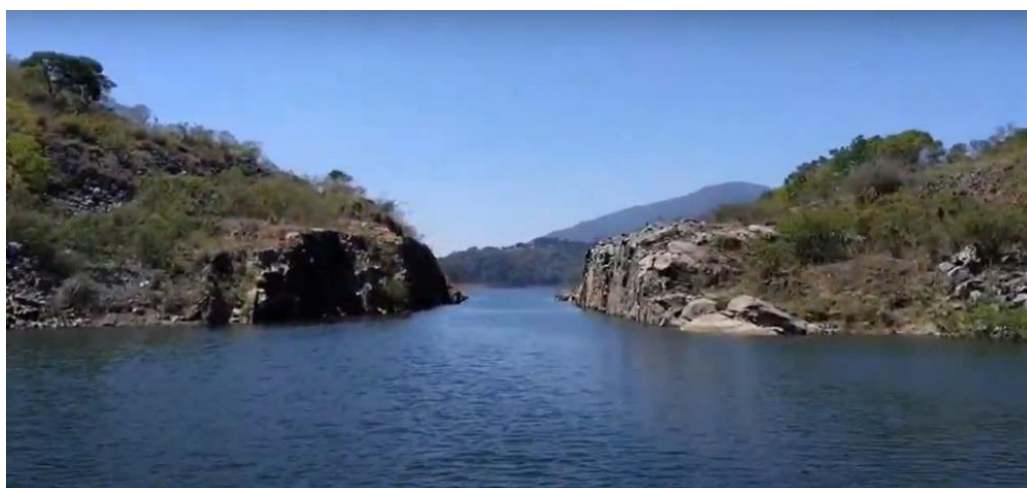
Figura 15 – Canal de interligação dos reservatórios Jaguari-Jacareí
