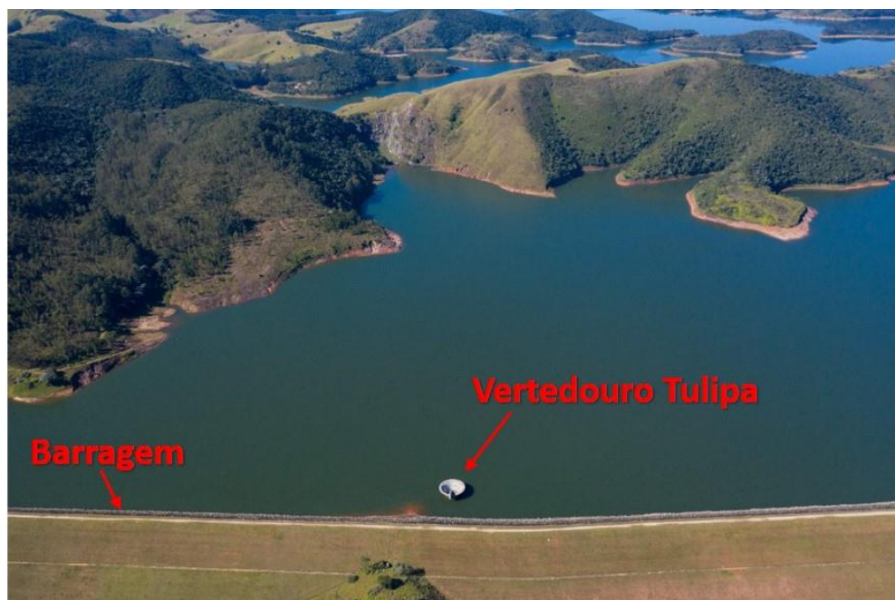
Figura 9 – Imagem da área do reservatório de Paraibuna, em destaque a barragem e o vertedouro tulipa
