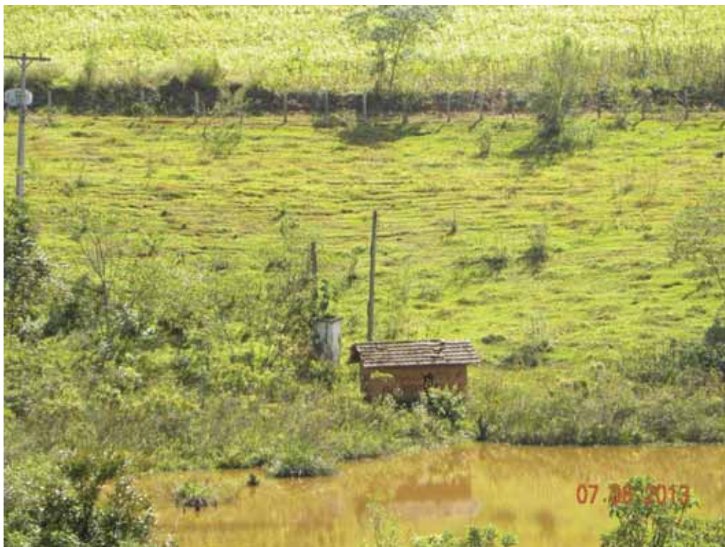
Figura 25. Visualização do processo de rastejo na encosta do lado esquerdo da barragem no ponto 4.
