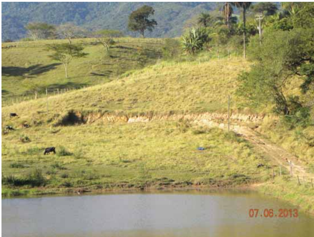
Figura 32. Visualização de processo erosivo na encosta do lado esquerdo da barragem no ponto 7, mas sem risco de movimento de massa.
