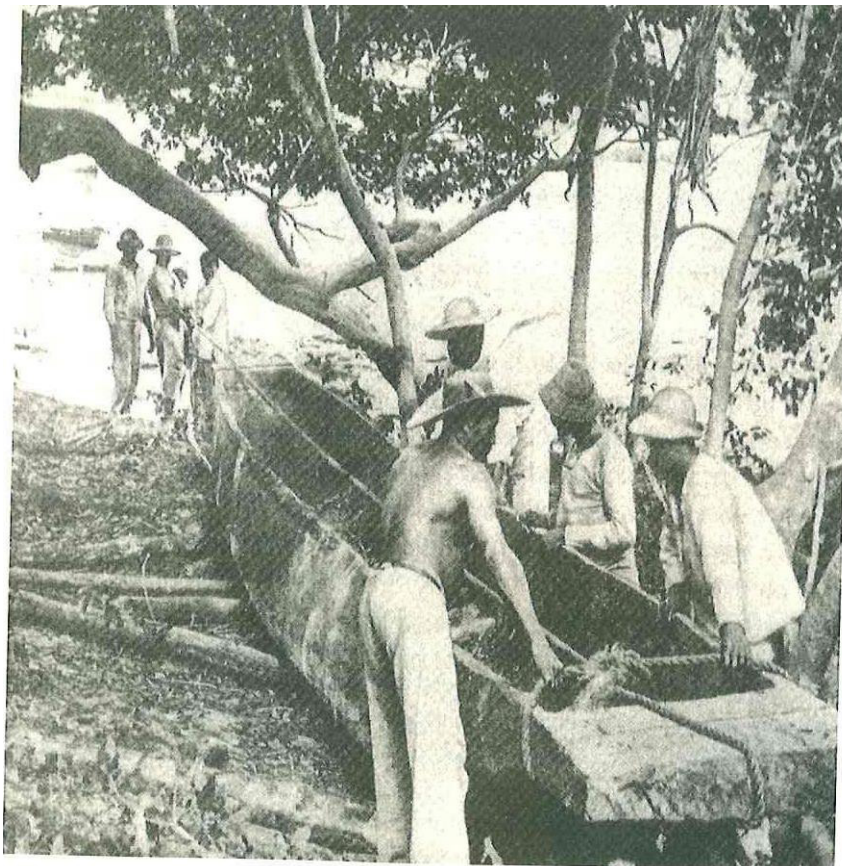
Imagem 17: Construção de uma canoa às margens do rio Tocantins
