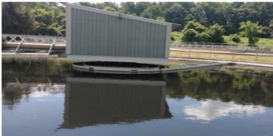
Figura 17 – Tanque de decantação secundária da ETE Sugar Creek .
