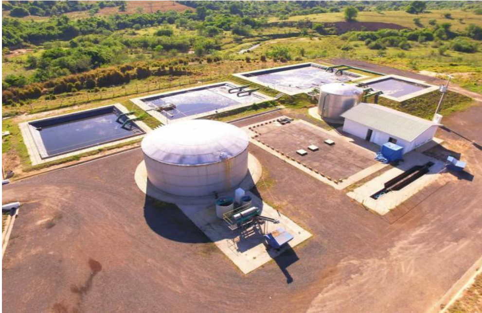
Figura 5 – Vista aérea da ETE Norte de Presidente Venceslau – SP.
