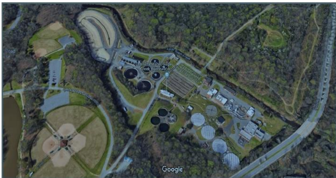
Figura 14 – Vista aérea da ETE Sugar Creek .
