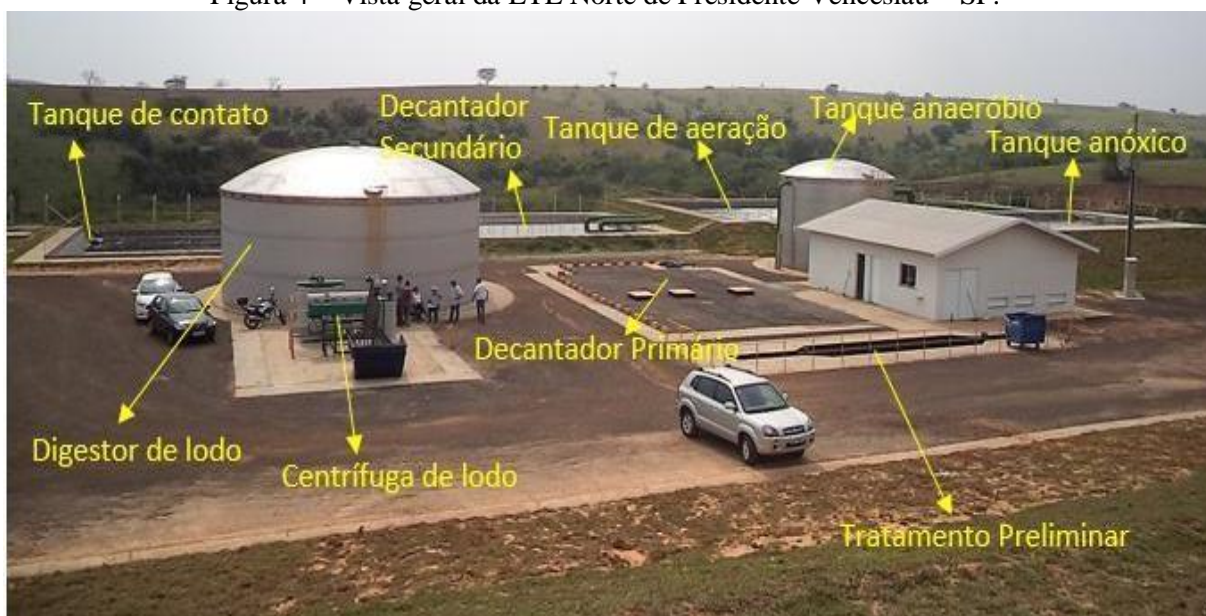
Figura 4 – Vista geral da ETE Norte de Presidente Venceslau – SP.
