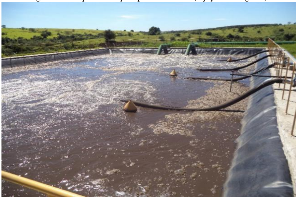
Figura 8 – Tanque de aeração após enchimento (injeção de oxigênio).
