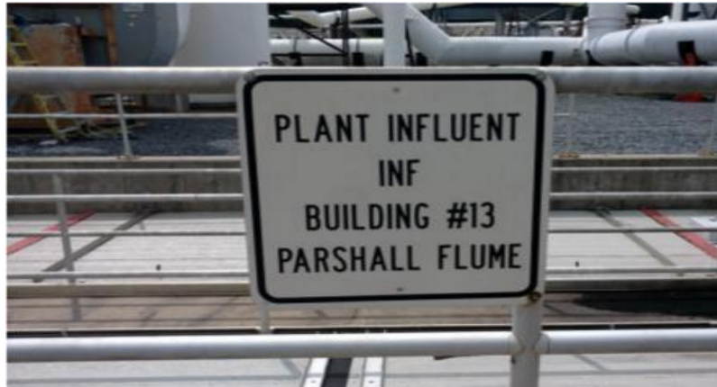
Figura 15 – Chegada do esgoto na calha parshal da ETE Sugar Creek .
