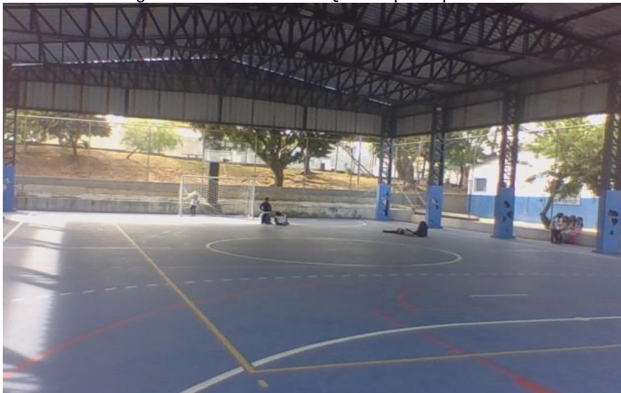
Figura 5: Área externa – Quadra poliesportiva
