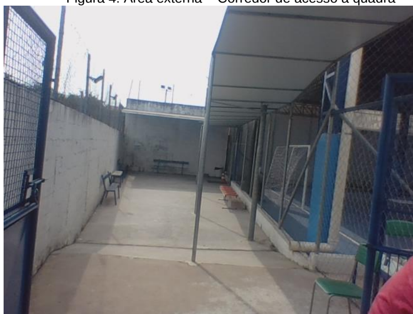
Figura 4: Área externa – Corredor de acesso à quadra
