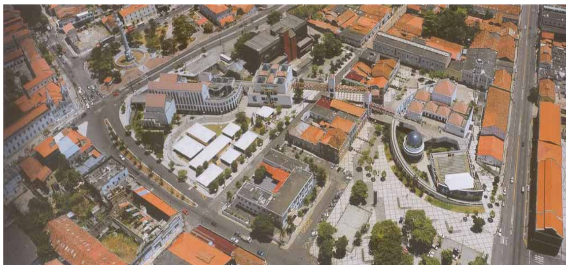
Figura 108. Vista geral do Centro Dragão do Mar de Arte e Cultura. Fonte: www.recem.files.wordpress.com/2009/08/panoramica dragao.jpg
