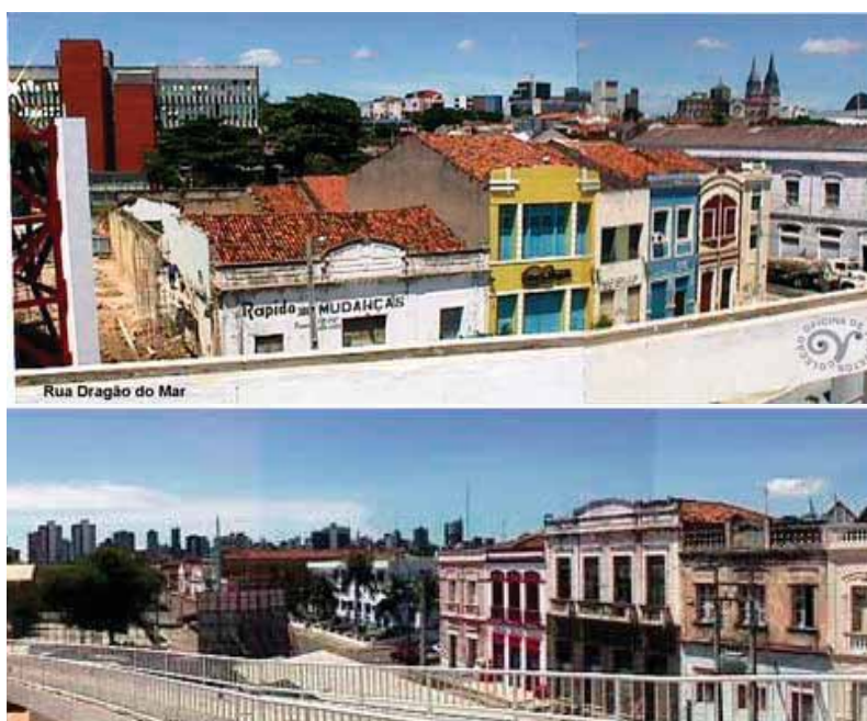
Figura 111. Casas da quadra Dragão do Mar mal cuidadas, ainda no início da construção do centro cultural.
