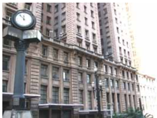
Figura 58. Fachada cor-de-rosa do Edifício Martinelli. Fonte: Arquivo pessoal.
