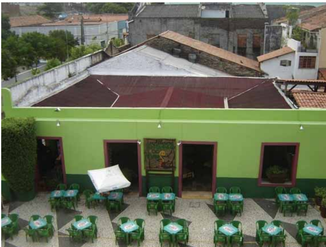
Figura 172. Casa número 309 vista desde a passarela metálica.
