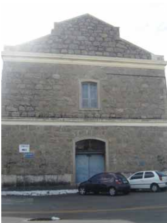
Figura 152. Lateral do prédio do grupo E com acesso pela Rua Almirante Tamandaré. Fonte: Arquivo pessoal.
