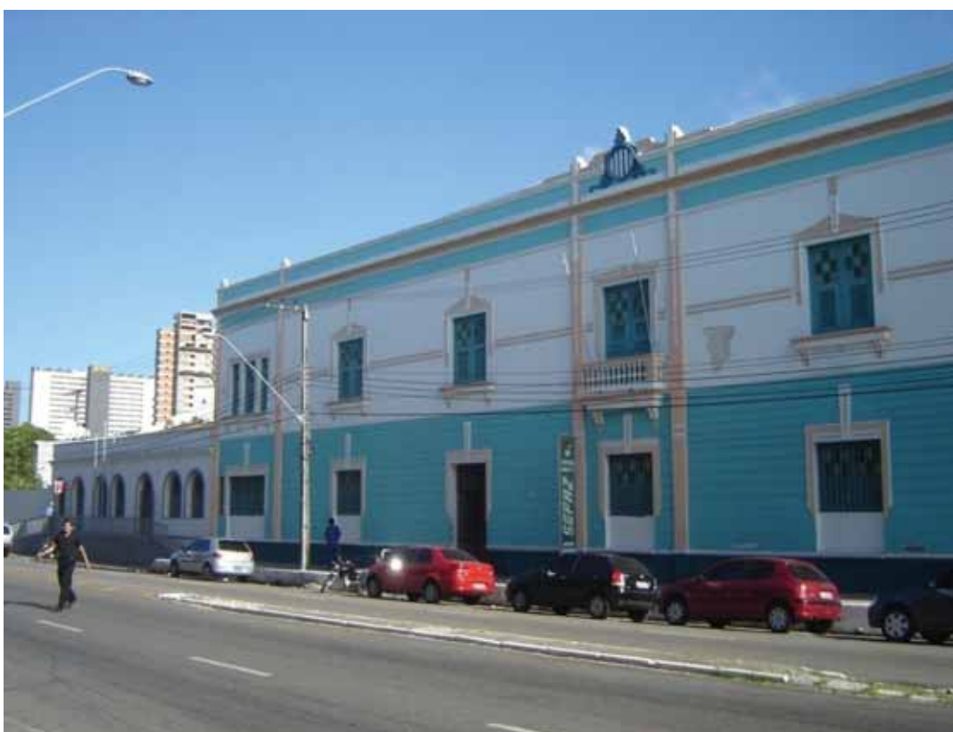
Figura 155. Conjunto do grupo F, da esquina da Rua Boris com a Av. Pessoa Anta. Fonte: Arquivo pessoal.
