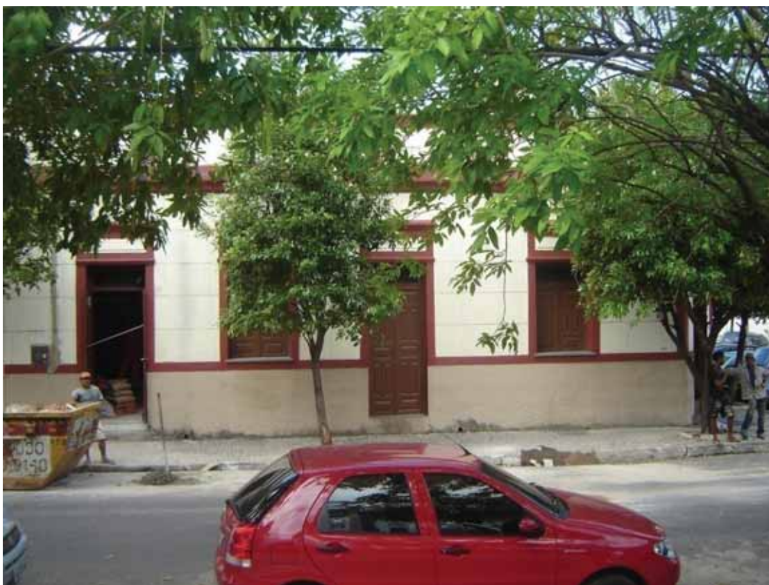
Figura 177. Casa 387 do grupo M sendo reformada.
