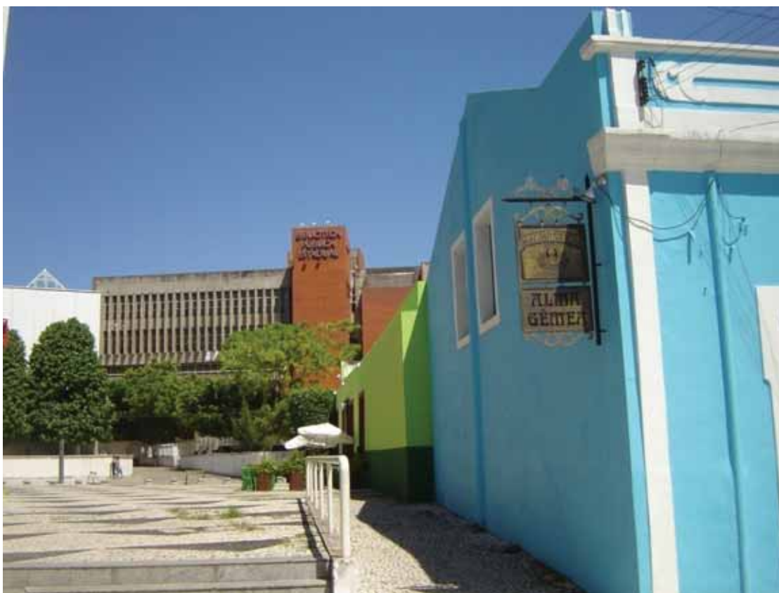
Figura 173. Conjunto referente ao grupo A-L, com vista para a Biblioteca Municipal.
