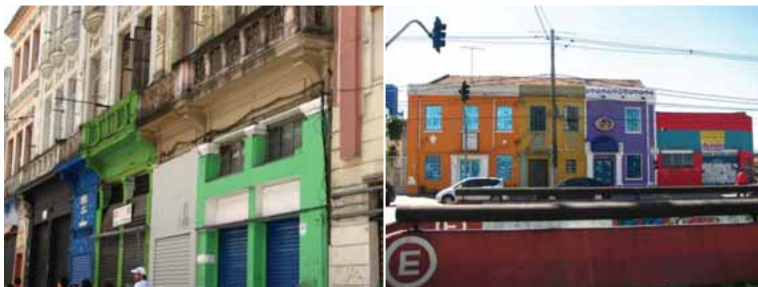
Figura 76. Exemplos de mau uso da cor em casas comerciais em São Paulo. Fonte: Arquivo pessoal.
