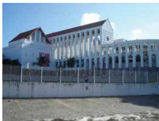
Figura 85. Vista do Setor Vermelho desde a Rua José Avelino, onde está o estacionamento.
