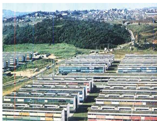
Figura 72. Vista geral do Conjunto CECAP.
