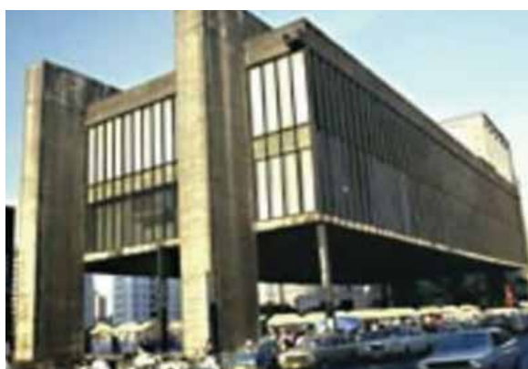
Figura 67. MASP em 1985 ainda em concreto aparente.
