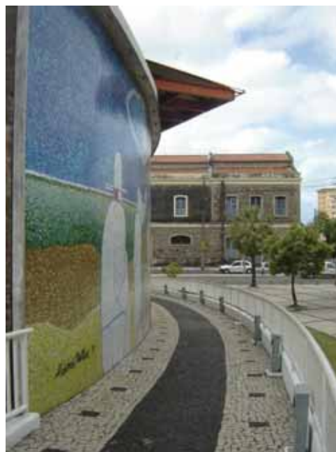
Figura 101. Rampa de acesso ao Setor Laranja. Fonte: Arquivo pessoal.
