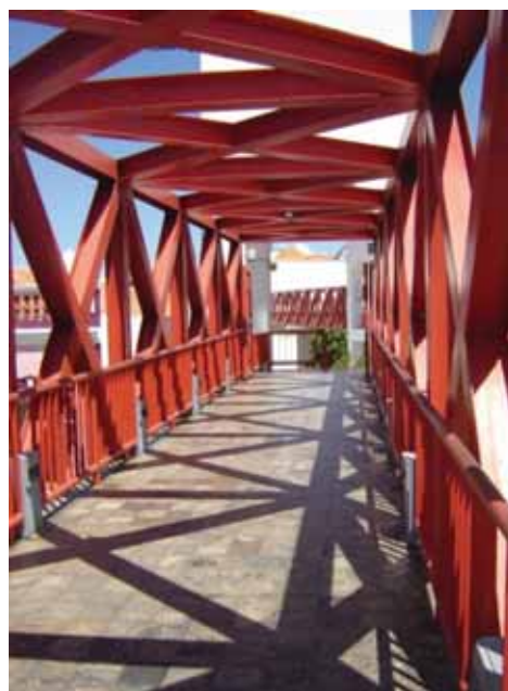
Figura 90. Interior da passarela. Fonte: Arquivo pessoal.
