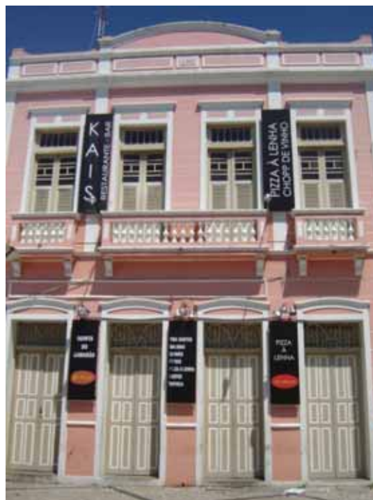
Figura 138. Detalhe da casa número 92 da Rua Dragão do Mar. Fonte: Arquivo pessoal.
