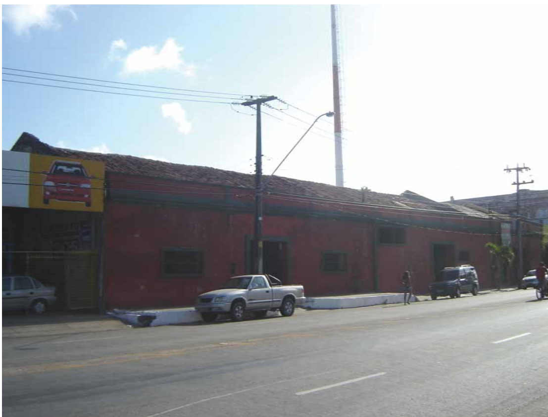
Figura 161. Falta de manutenção na casa número 154 do grupo H.
