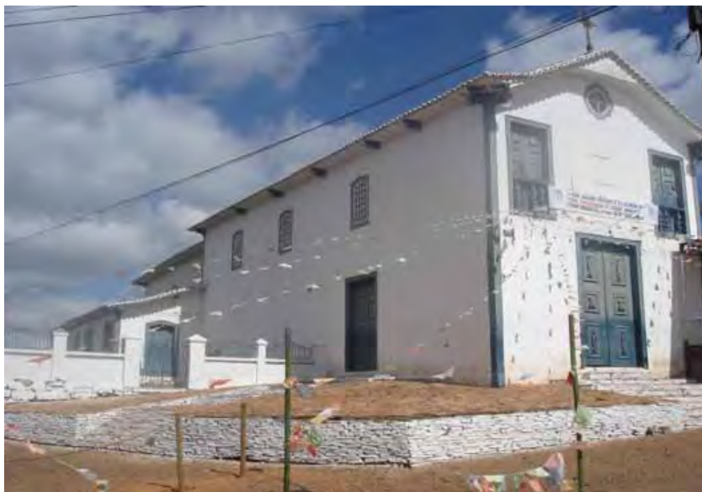
Fig. 14 – Capela de Nossa Senhora do Rosário, c. 1758. Serro, MG.
