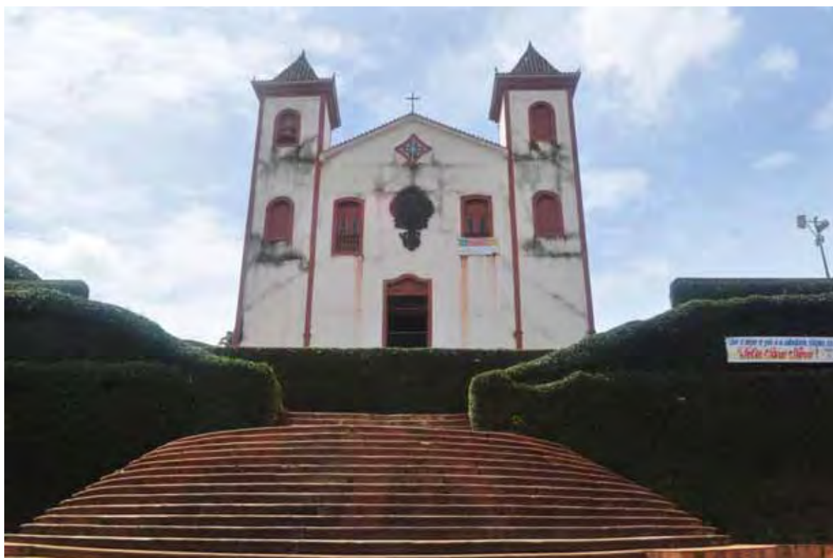
Fig. 7 – Igreja de Nossa Senhora do Carmo, c. 1768. Serro, MG.
