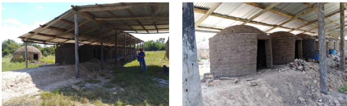
Figura 8 - Vista geral dos oito fornos com cobertura
