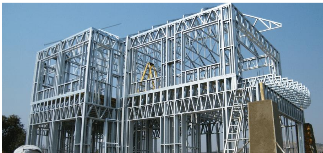
Figura 1 - Estrutura Residencial em Light Steel Frame
